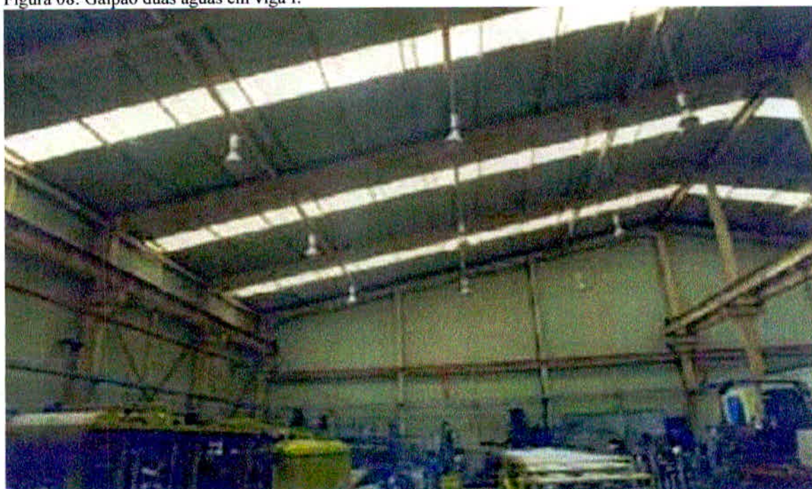
Figura 08: Galpão duas águas em viga I.
