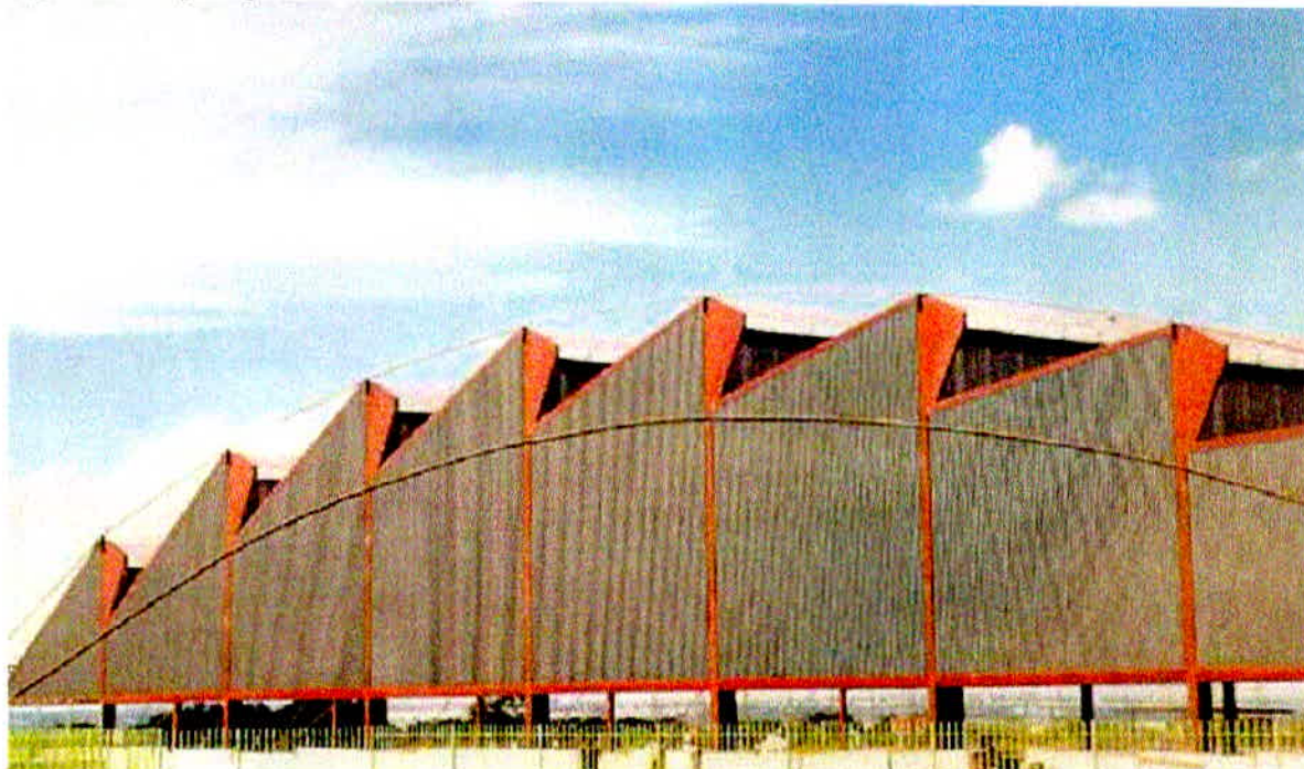
Figura 10: Galpão tipo Sched em treliça acabado.
