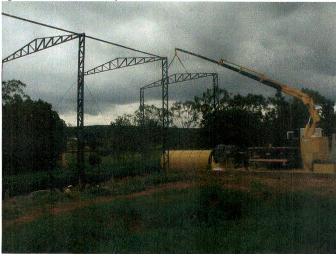
Figura 06: Pórtico e tesoura em treliça.
