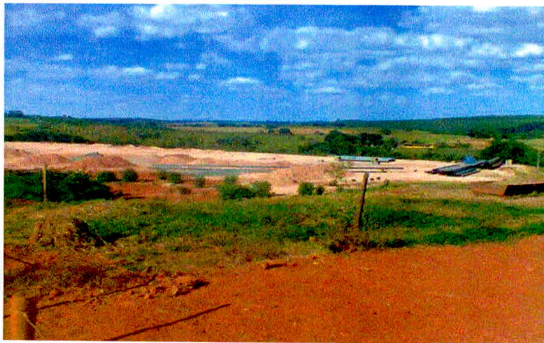
Figura 19: Serviço de terraplanagem
