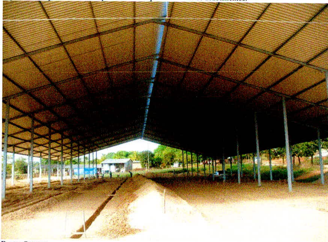
Figura 21: Galpão alma cheia tipo free stall no processo final de acabamentos.
