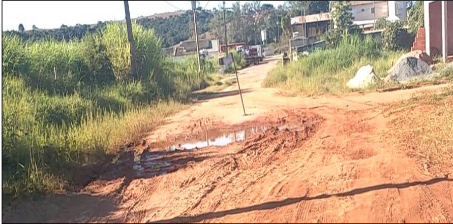
Figura 325 - Água empoçada na Avenida Capitão Reis
