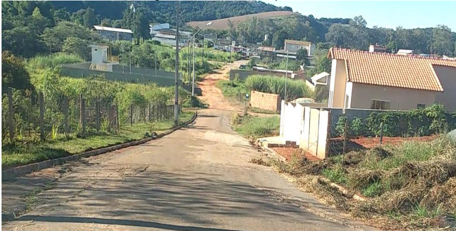
Figura 33 - Foto da Avenida Capitão Reis
