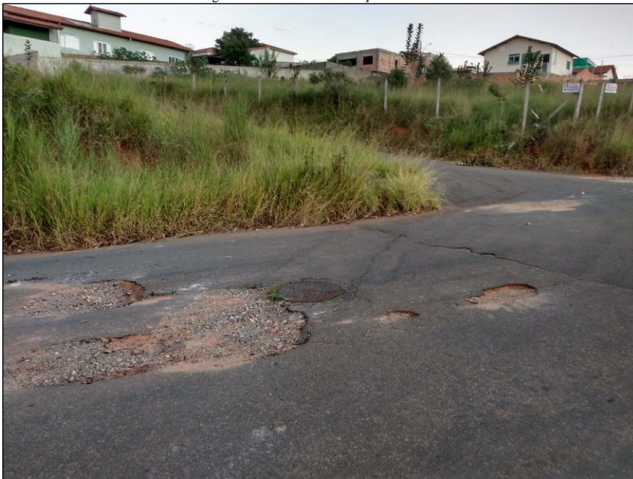
Figura 336 – Foto Pavimentação no bairro
