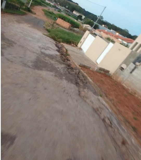
Figura 36 - Foto de um trecho da Avenida Capitão Reis
