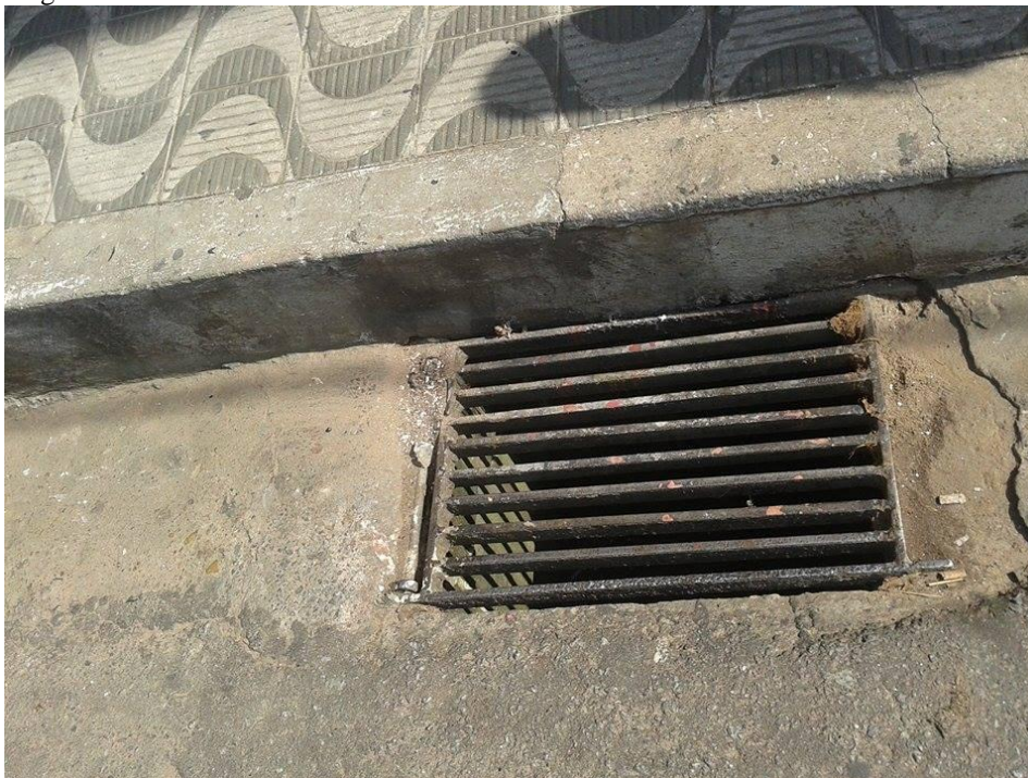
Figura 14: Boca-de-lobo em estado aceitável.
