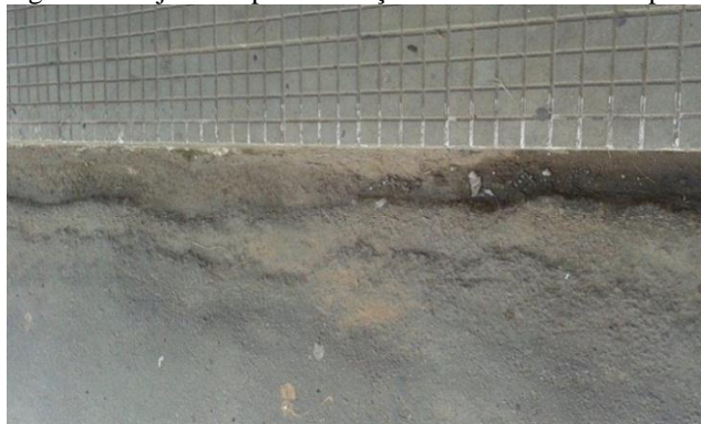
Figura 5: Sarjeta em pavimentação asfáltica na Av. Dep. Carlos Luz.
