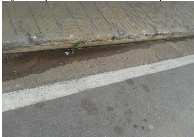
Figura 4: Sarjeta em concreto na Rua José Henrique da Costa
