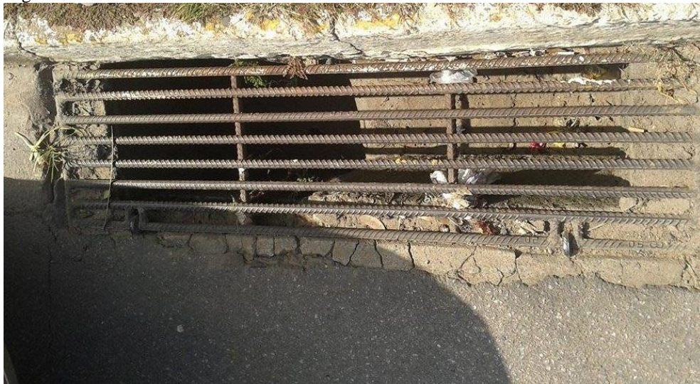
Figura 15: Boca-de-lobo em estado aceitável.
