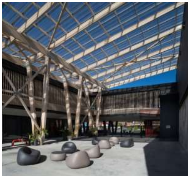
Figura 30 – Vista do pátio
