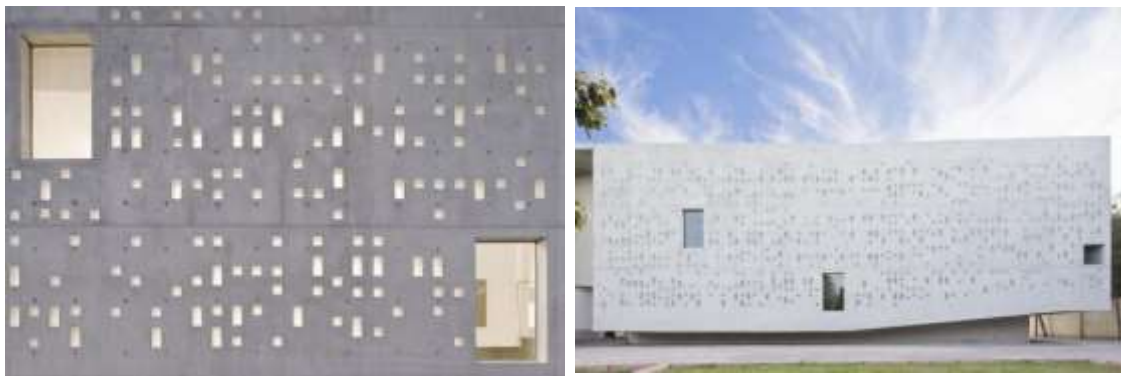
Figura 31 – Detalhe da fachada
