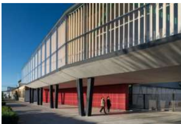
Figura 29 – Vista da fachada
