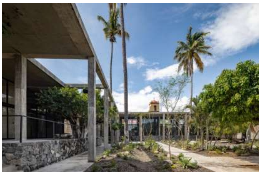
Figura 33 – Vista do pátio
