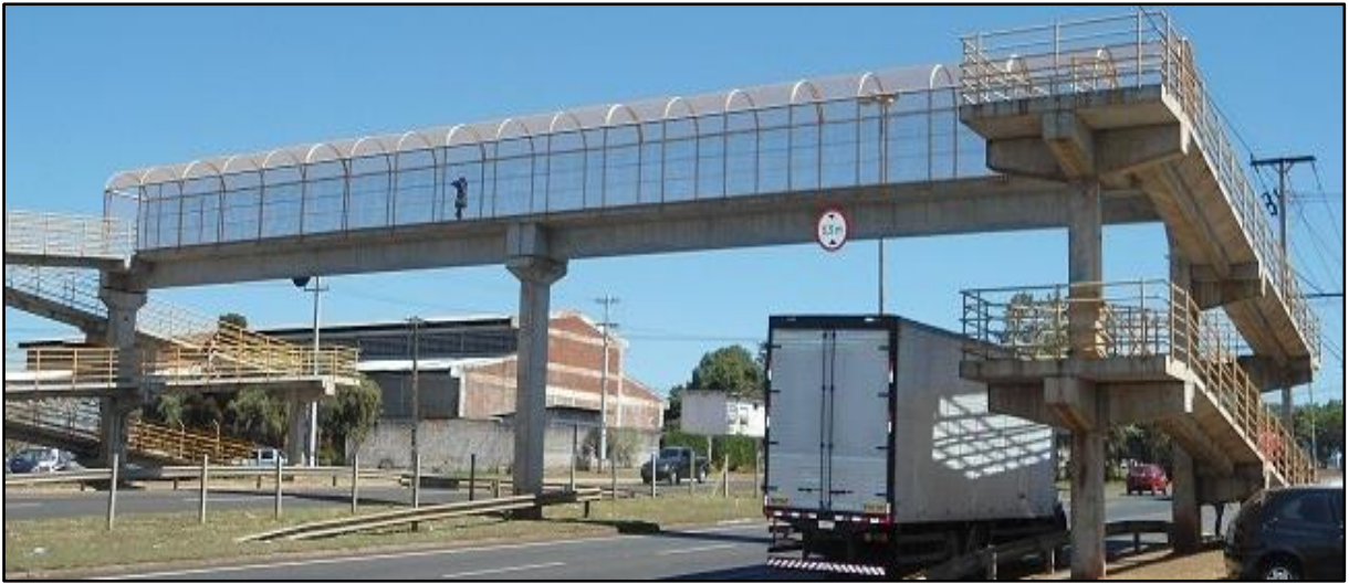
Figura 01 – Passarela executada em concreto.
