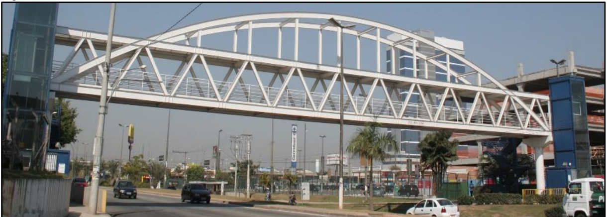
Figura 02 – Passarela executada em estrutura metálica e concreto armado.
