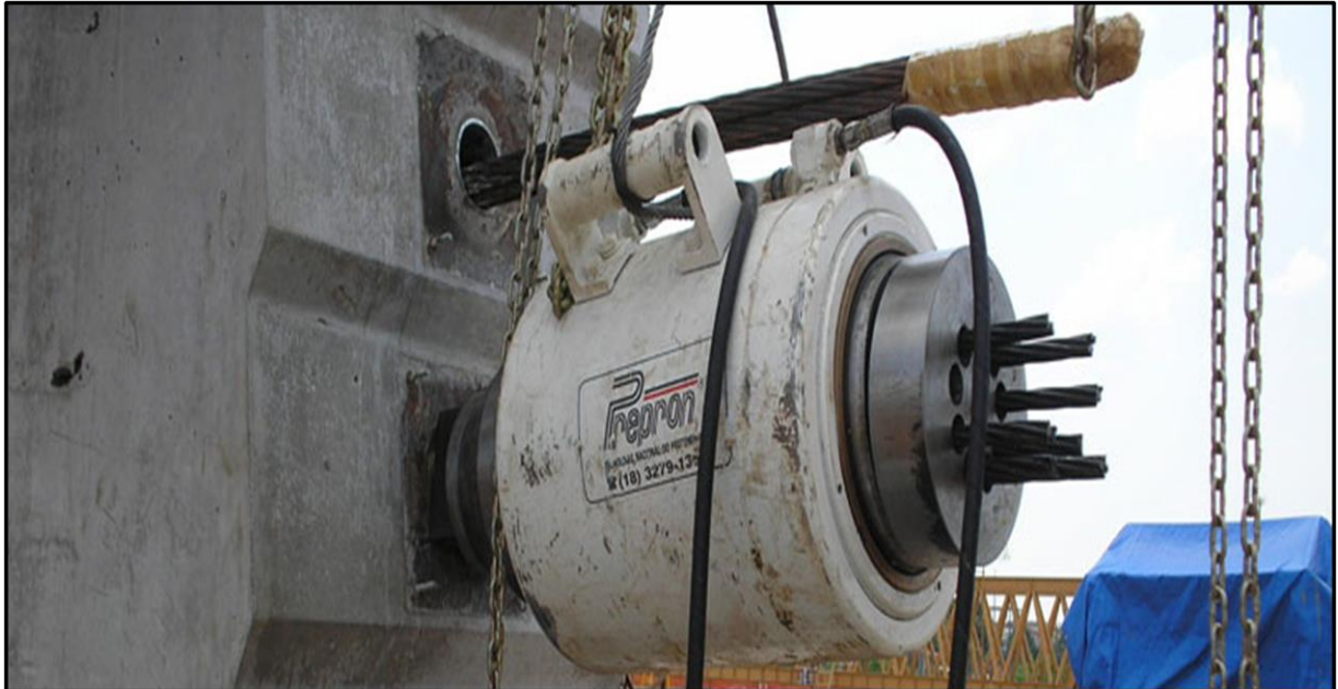
Figura 07 – Vista de um bloco de ancoragem e cunha.
