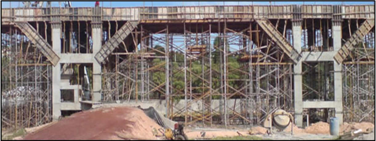
Figura 03 – Escoramento de vigas de grande porte.
