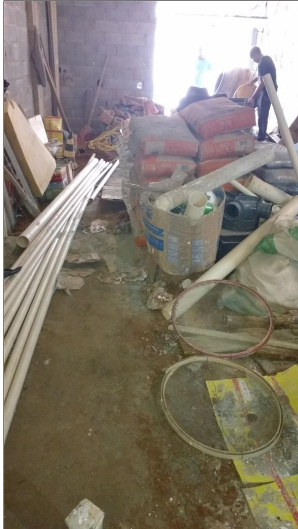
Figura 3 - Materiais dispostos no canteiro de obra.
