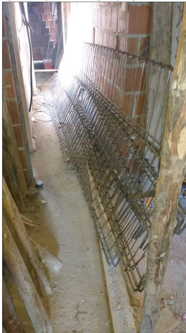
Figura 4 - Viga obstruindo a passagem pelo corredor.
