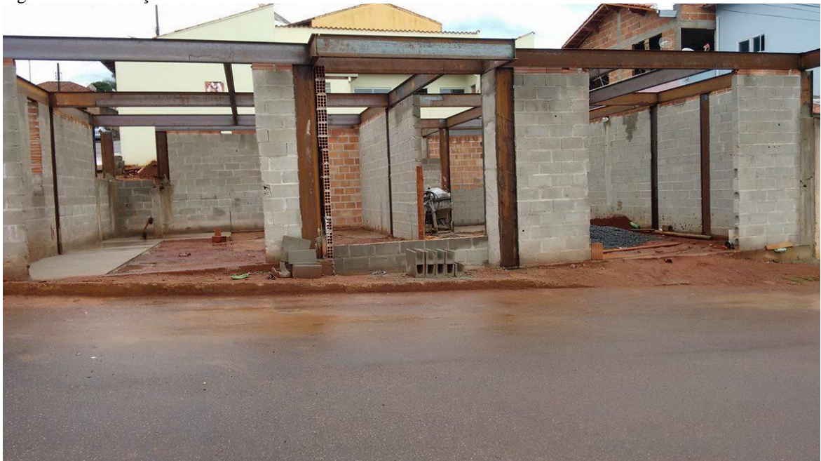
Figura 07 – Instalação de Estrutura Metálica no Pavimento Térreo
