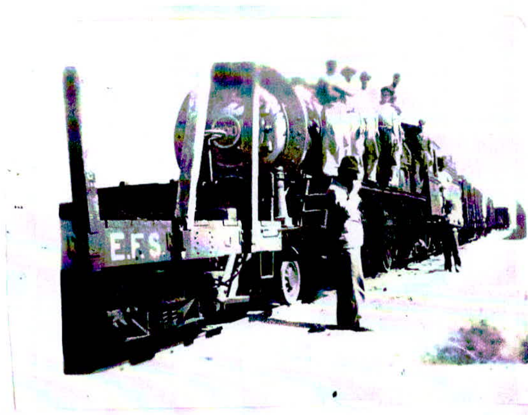
Engenheiros no local da futura Estação Ferroviária, 1933. Foto: Acervo Pessoal.
