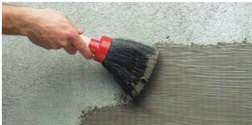
Figura 11 - Aplicação de argamassa polimérica sob forma de pintura
