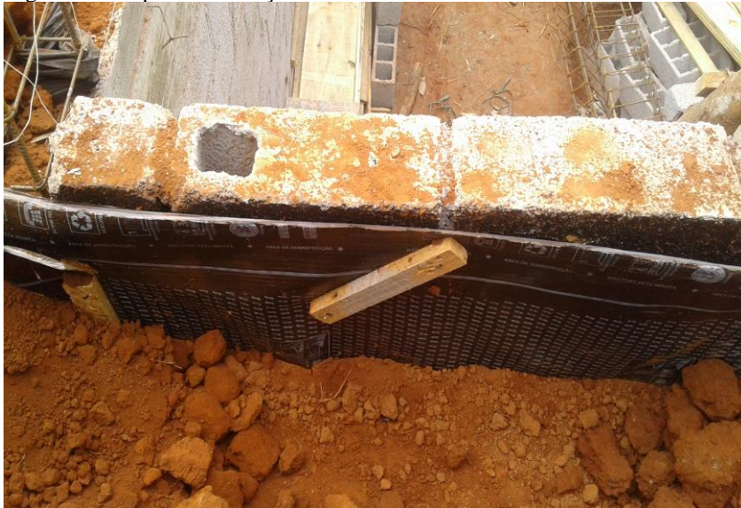
Figura 23 - Impermeabilização com manta asfáltica no muro de arrimo 1
