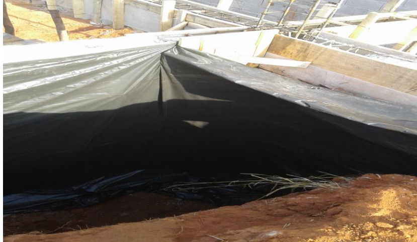
Figura 24 - impermeabilização no muro de arrimo 2
