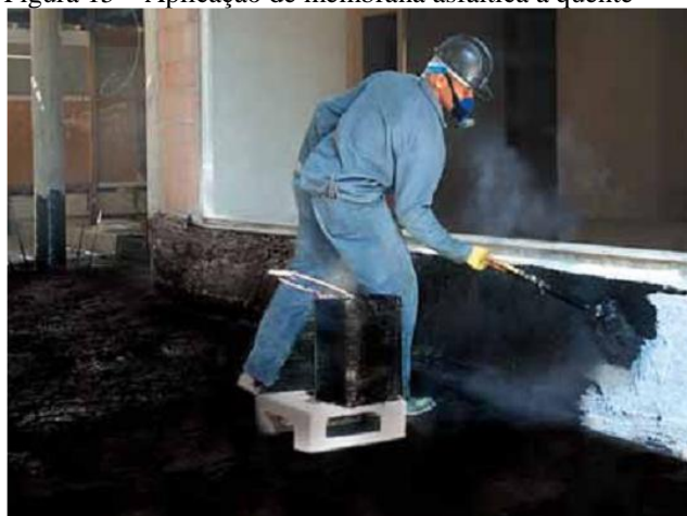
Figura 15 – Aplicação de membrana asfáltica a quente
