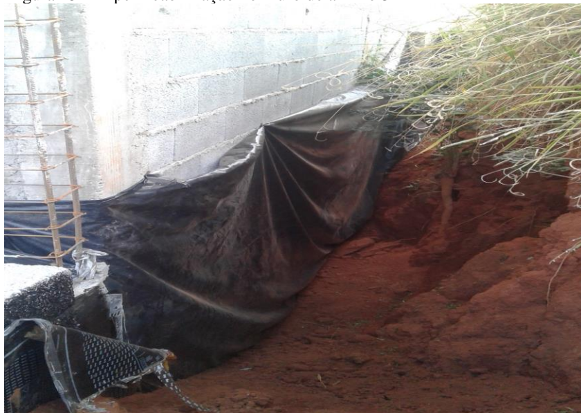
Figura 25 - Impermeabilização no muro de arrimo 3
