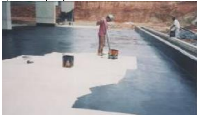
Figura 13 - Aplicação de membrana asfáltica a frio
