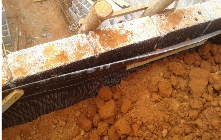
Figura 22 - Impermeabilização com manta asfáltica no muro de arrimo 1
