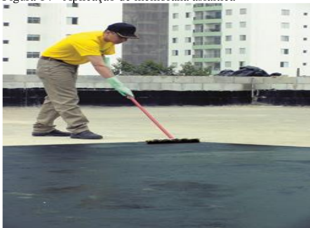
Figura 14 - Aplicação de membrana asfáltica
