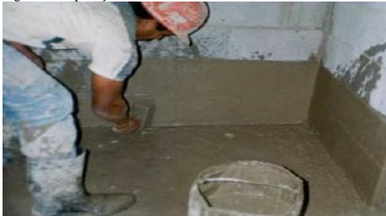
Figura 16 – aplicação de membrana acrílica
