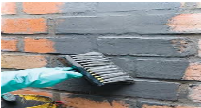
Figura 08 - Aplicação de Cristalizantes na forma de pintura
