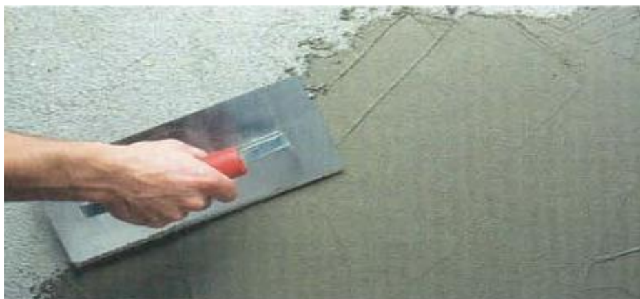
Figura 12 - Aplicação de argamassa polimérica sob forma de revestimento
