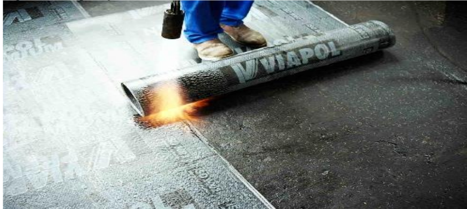
Figura 19 – Aplicação de manta asfáltica 3
