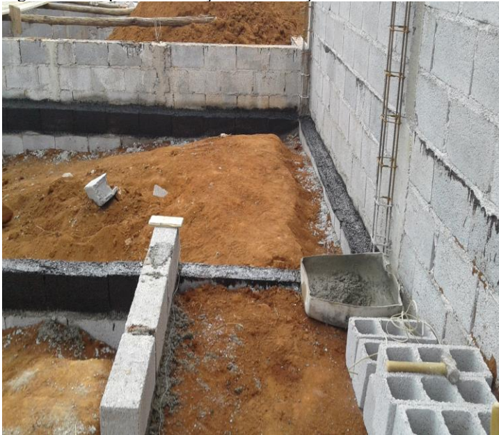
Figura 27 - impermeabilização em fundação
