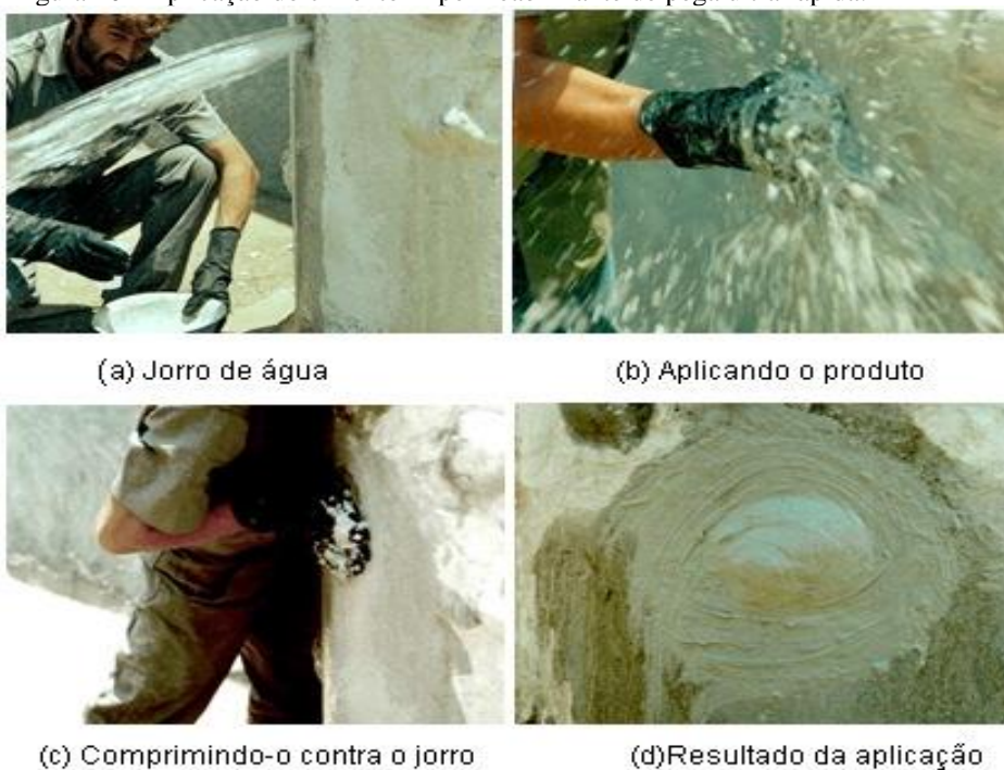
Figura 10 - Aplicação do cimento impermeabilizante de pega ultra rápida.
