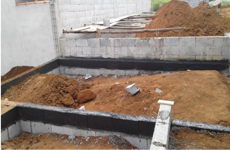
Figura 26 - Impermeabilização em fundação
