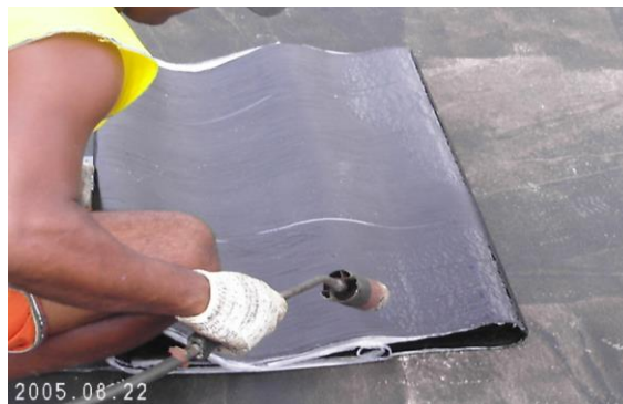
Figura 18 - Aplicação de manta asfáltica 2
