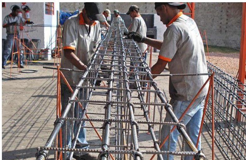
Figura 06: Montagem de armadura utilizada em elemento estrutural
