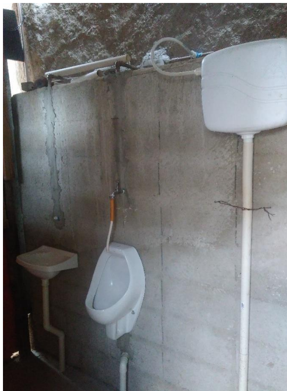
Figura 25: Instalação sanitária em canteiro de obra.
