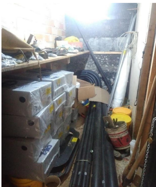
Figura 24: Almojarifado localizado no canteiro de obras.
