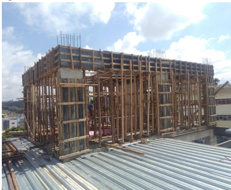
Figura 42: Estrutura em sistema construtivo concreto armado.
