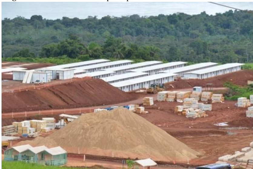
Figura 02: Canteiro de obras tipo amplo.
