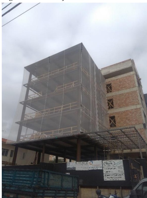
Figura 33: Edificação base do estudo de caso.
