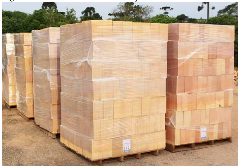
Figura 48: Armazenamento correto de tijolos cerâmicos no canteiro de obras.
