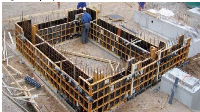
Figura 05: Aplicação de fôrmas de madeira.
