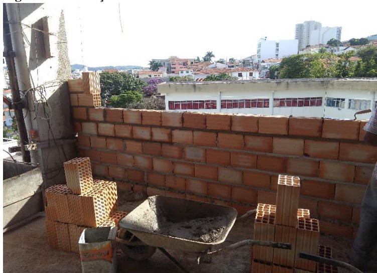
Figura 53: Execução de alvenaria no canteiro de obras.
