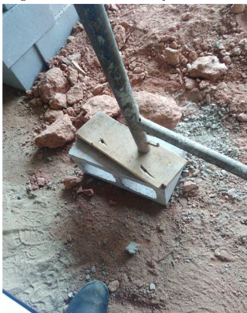
Figura 36: Andaime com calço.
