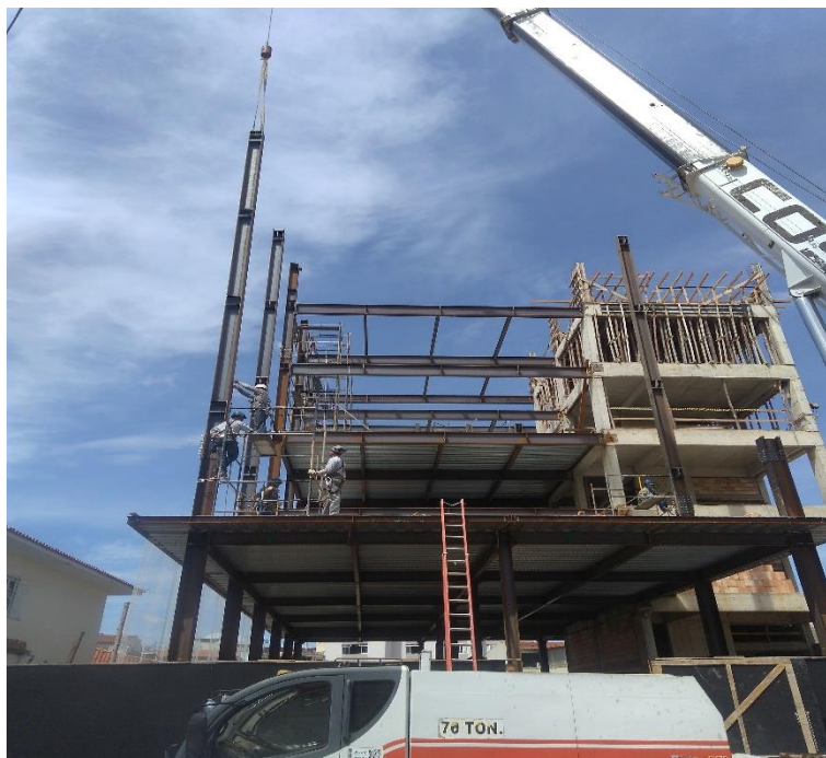
Figura 43: Execução de estrutura metálica.
