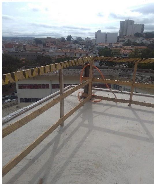
Figura 37: Guarda corpo instalado na edificação.
