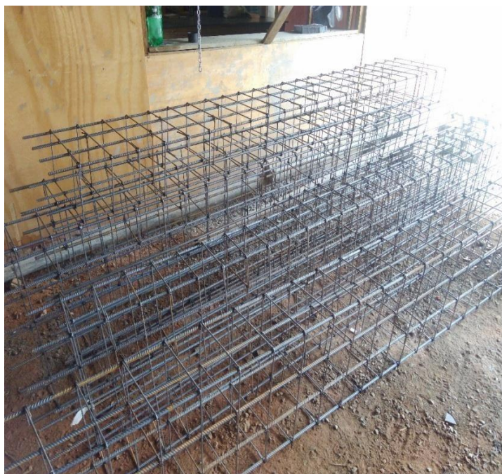
Figura 15: Armadura de aço utilizadas em elementos estruturais.
