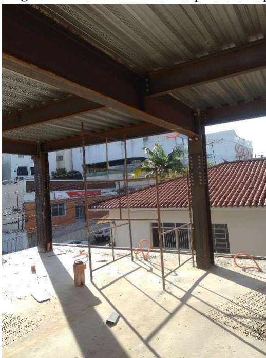
Figura 35: Andaime montado no pavimento tipo.
