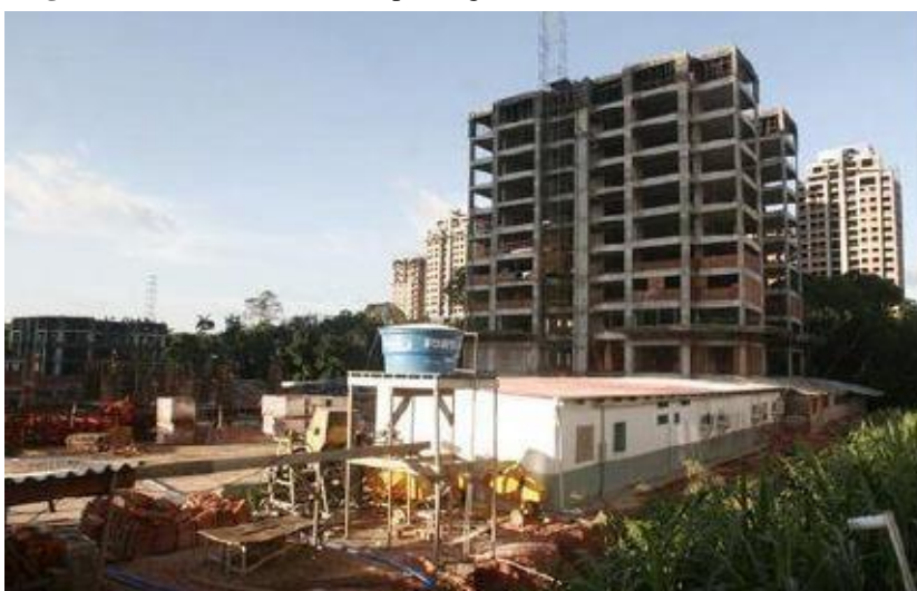
Figura 03: Canteiro de obras tipo longo e estreito.
