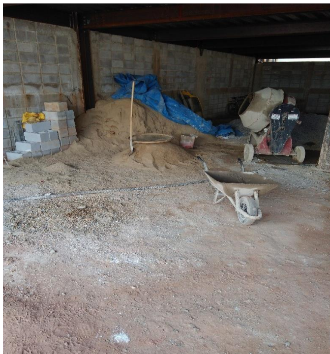
Figura 12: Central de concreto instalada na obra.
