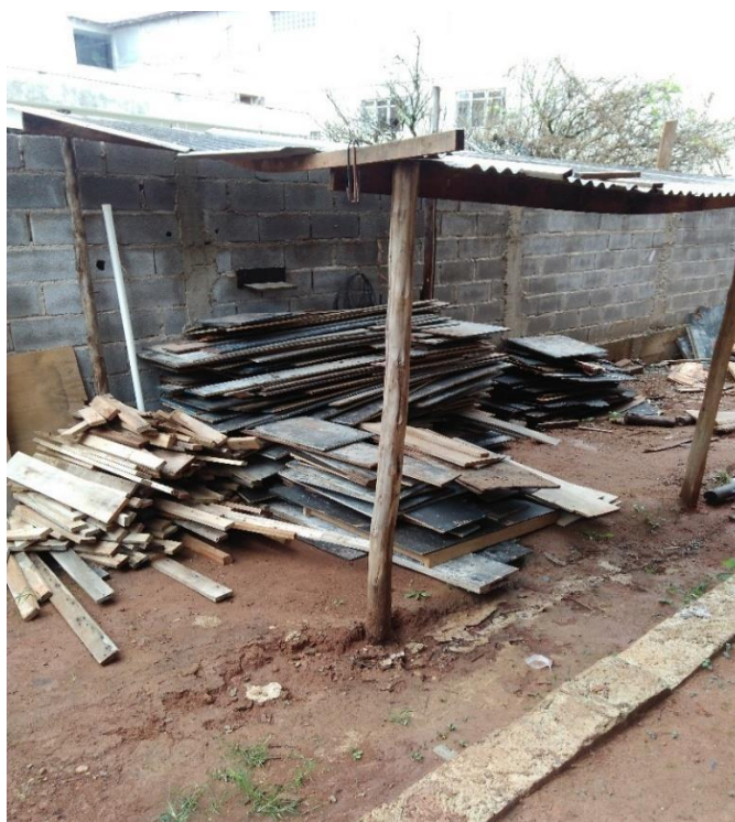
Figura 13: Central de fôrmas utilizada na obra.
