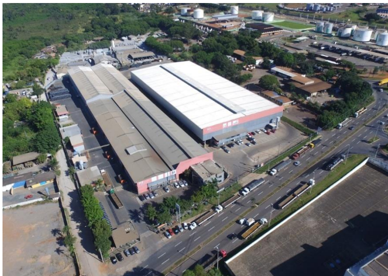
Figura 11 - Galpão industrial em estudo
