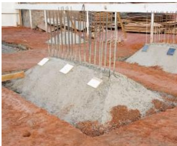
Figura 3 - Fundação rasa em sapata
