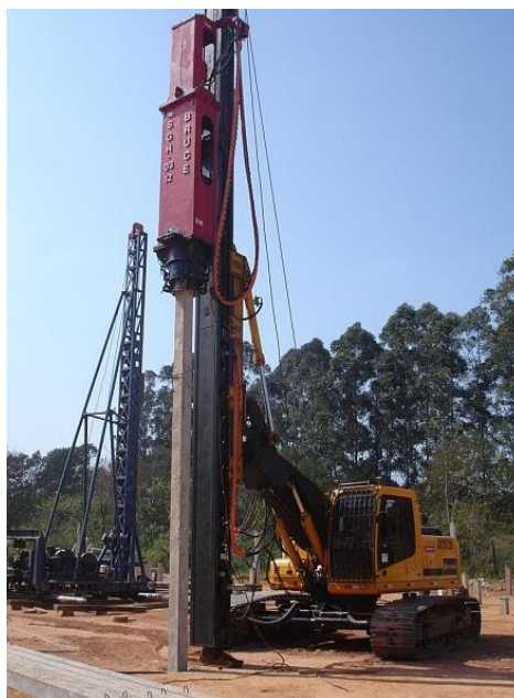
Figura 6 - Bate-estacas hidráulico
