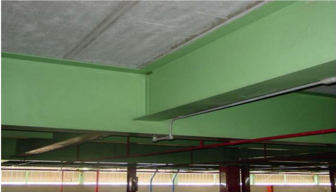
Figura 36-Exemplo de ligações soldadas.
