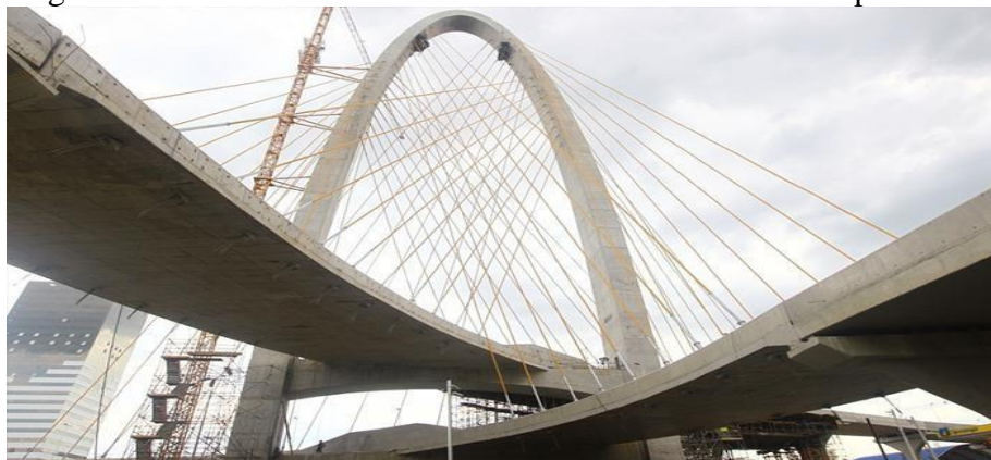
Figura 11: Ponte de estaiada com arco de São José dos Campos – SP.
