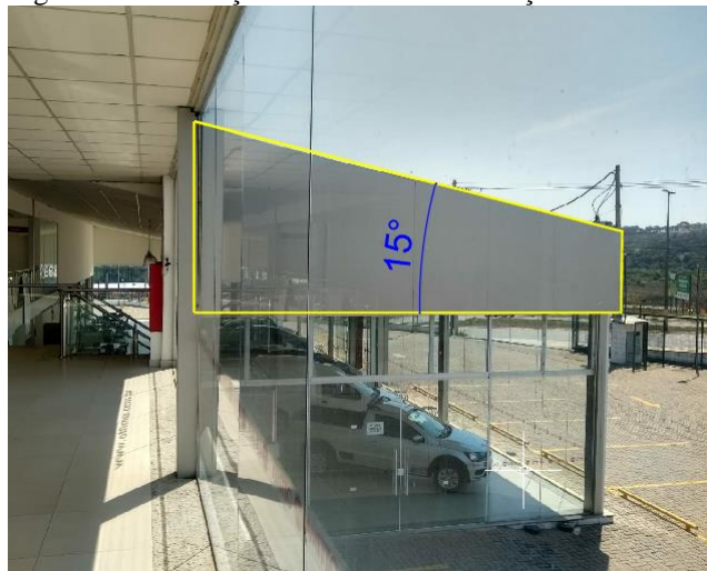
Figura 21 - Inclinação do telhado da instalação
