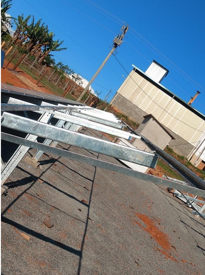
Figura 29 – Montagem da estrutura
