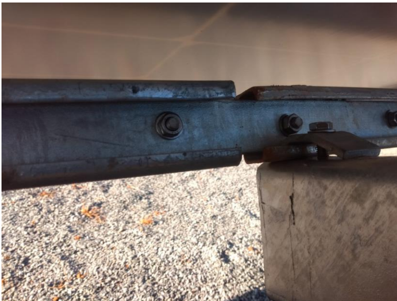
Figura 18 – Junção fora do braço longitudinal
