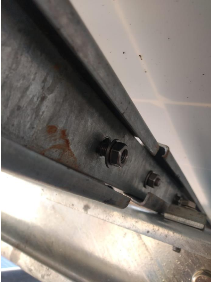
Figura 25 – Parafuso da junção sem o torque correto
