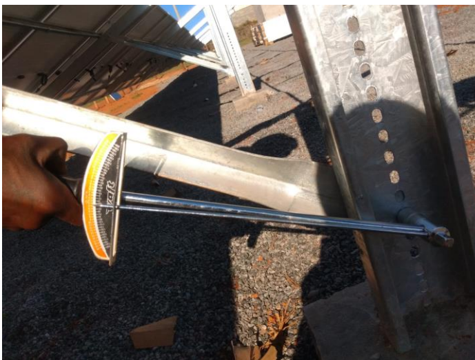
Figura 32 – Aplicação do torque no pilar, juntamente com a mão francesa
