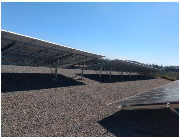
Figura 16 – Estrutura montada com os módulos
