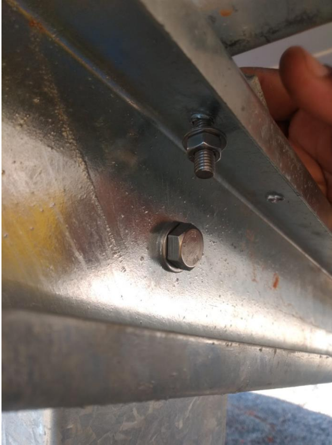
Figura 28 – Parafuso do grampo sem o torque
