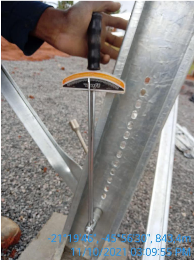
Figura 34 – Aplicação e conferência do torque no pilar
