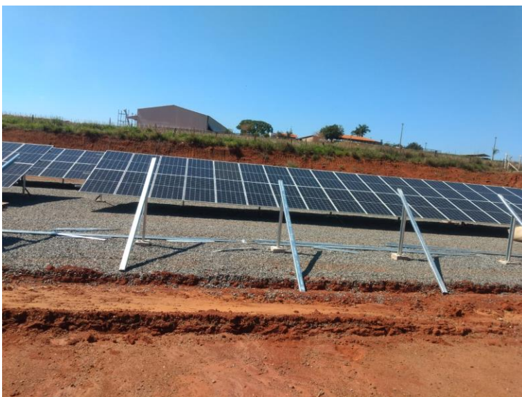
Figura 20 – Estrutura aguardando as novas mãos francesas
