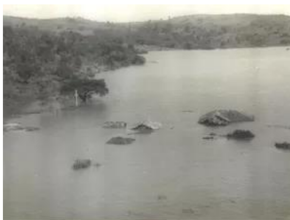
Figura 08: Inundação na cidade de Guapé
