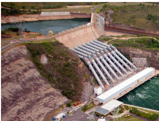
Figura 04: Barragem de Furnas
