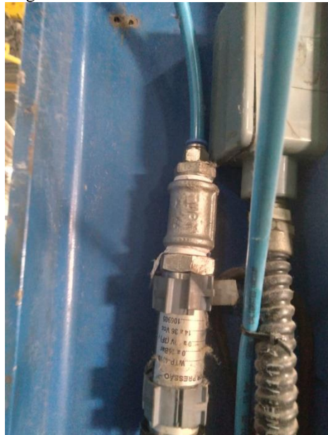
Figura 36–Transdutor de Pressão.
