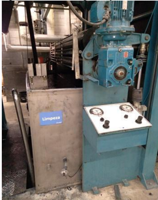
Figura 16 - Caixa de lavagem/limpeza.
