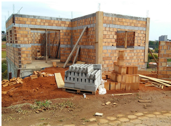
Figura 1 - Imagem de uma residência em fase de construção pelo sistema convencional em alvenaria.
