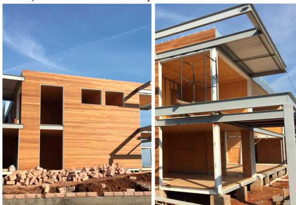
Figura 2 - Imagem de uma residência em fase de construção pelo sistema modular, utilizando estruturas em aço e combinando com painéis de madeira.
