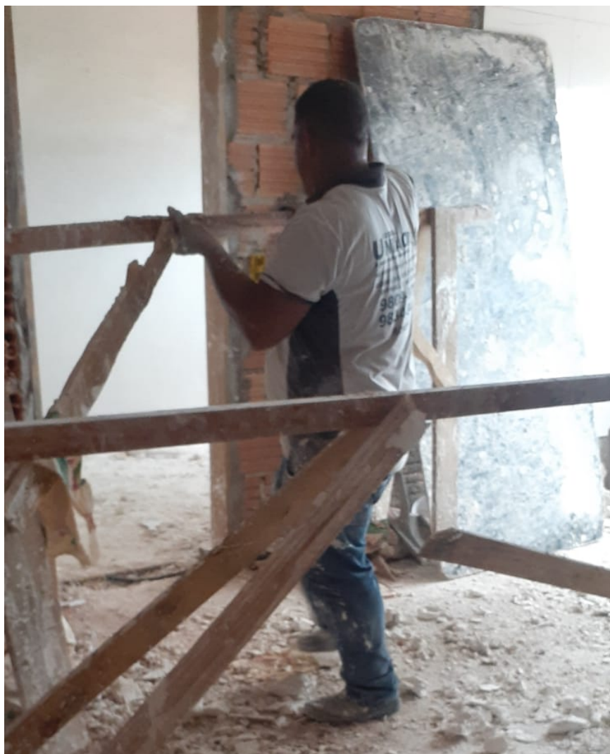
Figura 1: Foto da obra durante a realização
