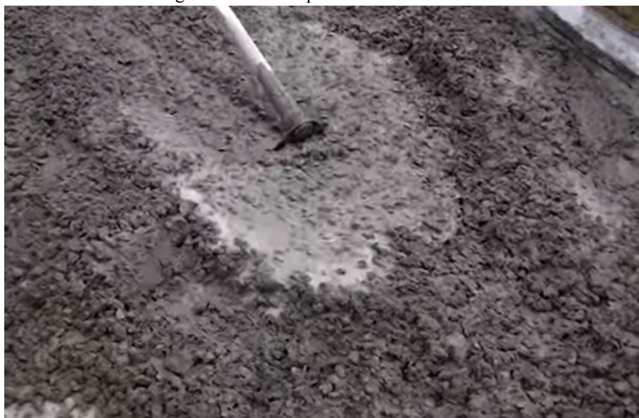
Figura 2: Concreto produzido em betoneira.
