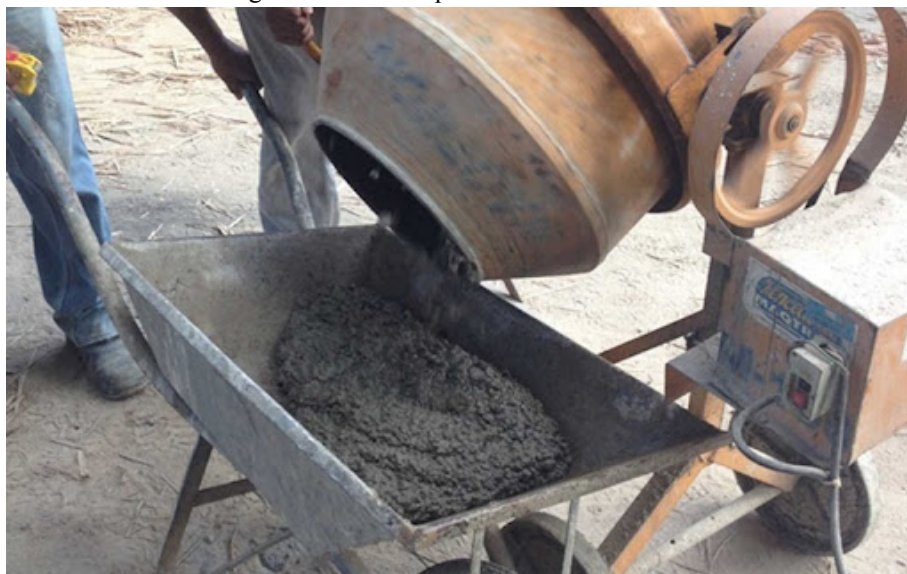
Figura 1: Concreto produzido em betoneira.
