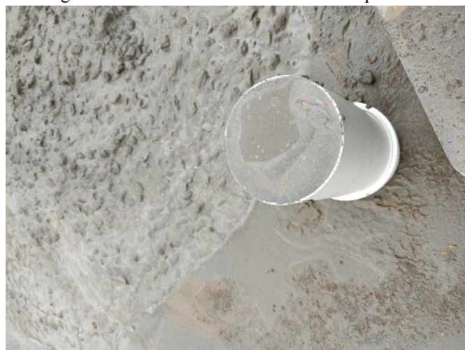
Figura 6: Arrasamento com uma colher de pedreiro.
