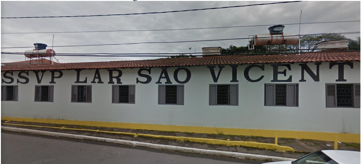
Figura 20 - Fachada vista da rua
