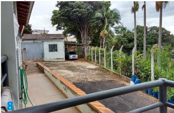
Figura 30 – vista da edificação à ser demolida
