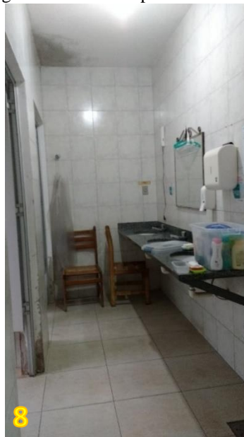
Figura 44 – vista da pia do banheiro
