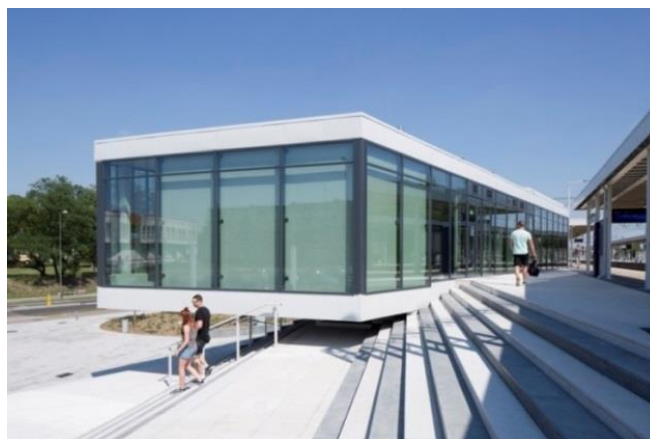
Imagem 46- Edifício e escadas
