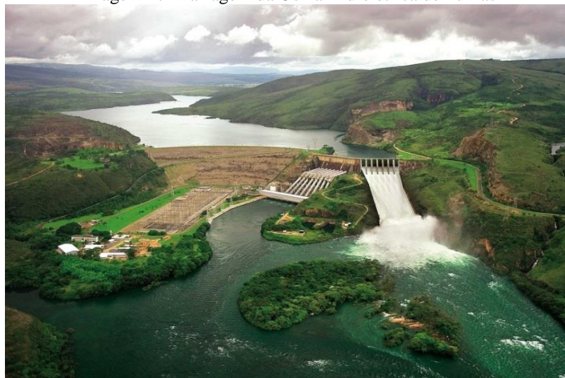
Imagem 17- Barragem da Usina Hidrelétrica de Furnas
