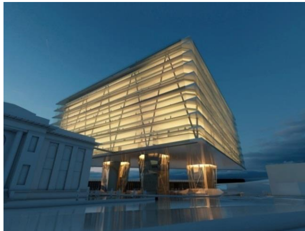
Imagem 43- Perspectiva da altura do edifício
