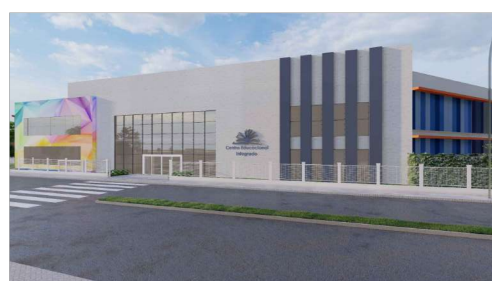
Figura 09 - Vista da Fachada
