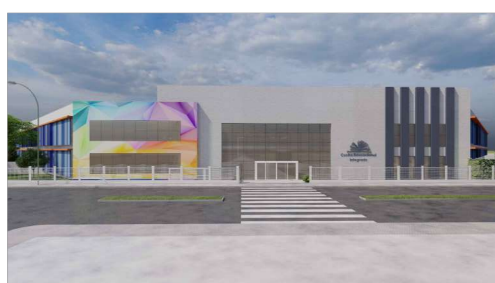
Figura 07 - Vista da Fachada
