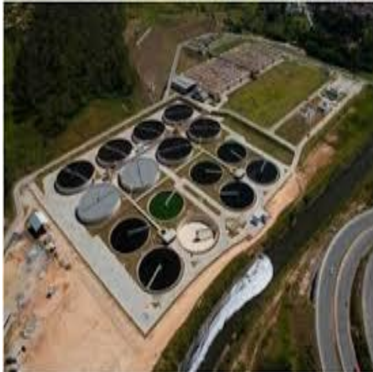
Figura 18 - Reatores anaeróbios de fluxo ascendente e manta de lodo, combinada a um dispositivo de filtro biológico implantado no município de Belo Horizonte – MG, ETE Onça.
