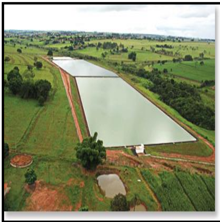
Figura 08 - Lagoa de estabilização implantada no município de Tanabi - SP. Lagoa anaeróbia seguida por lagoa facultativa.
