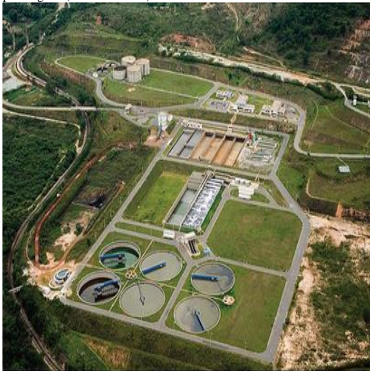
Figura 13 - Sistema de lodos ativados implantado no município de Belo Horizonte – MG, ETE Arrudas. Lodos ativados – aeração prolongada (fluxo contínuo).
