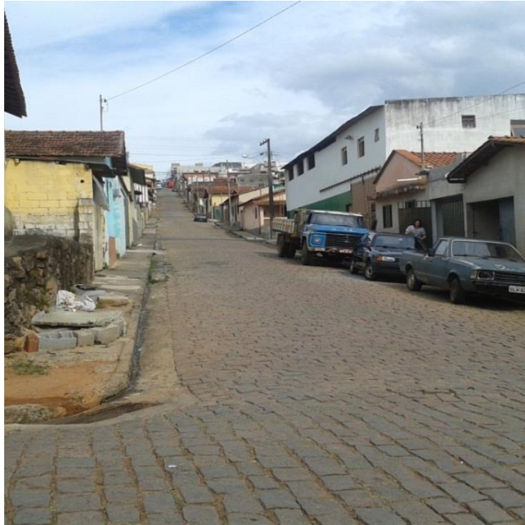
Figura 25 - Foto do trecho em estudo, localizado à Rua Sete de Setembro, em 05/2014.
