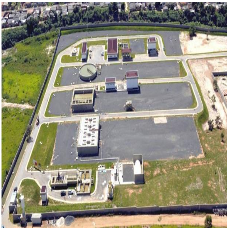
Figura 11- Sistema anaeróbio de manta de lodo implantado no município de Campinas – SP, no bairro Capivari. Reator anaeróbio com fluxo ascendente com manta de lodo.
