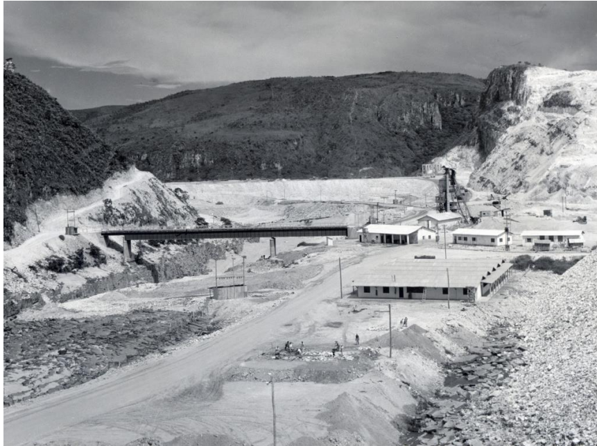
Figura 3 - Construção da Hidrelétrica
