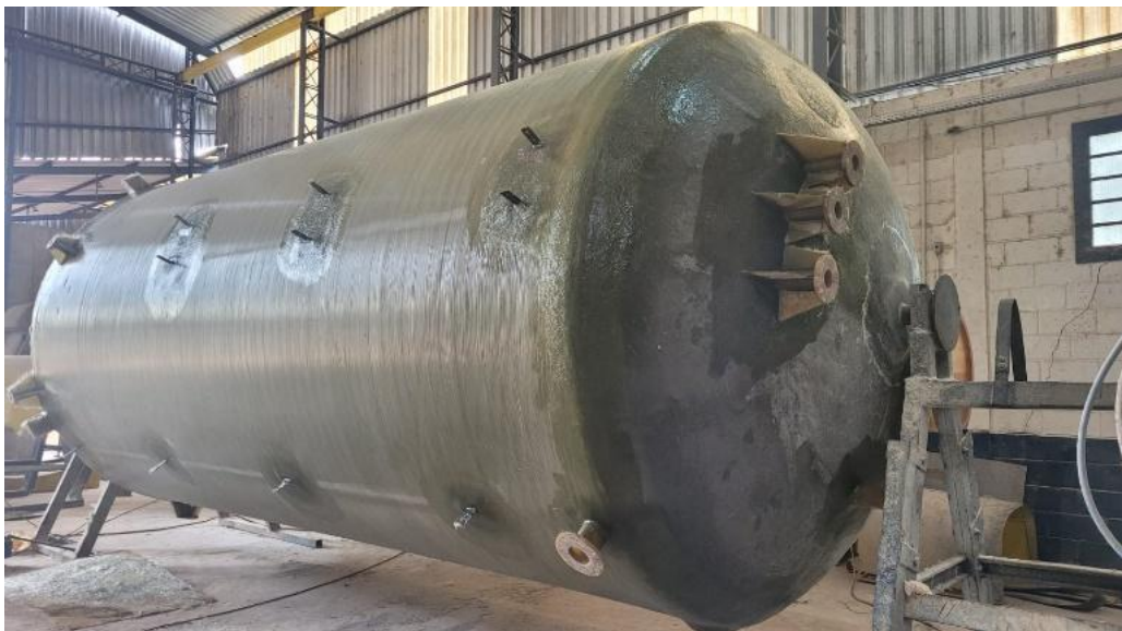
Figura 24- Instalação de acessórios.
