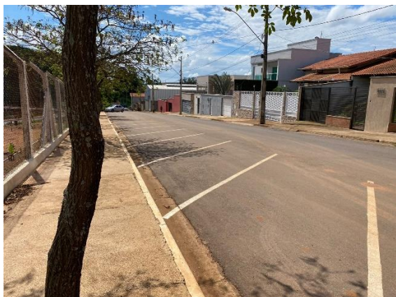
Figura 13: Calçada estreita e com obstáculo Fonte: Feito pela autora Ano: 2021
