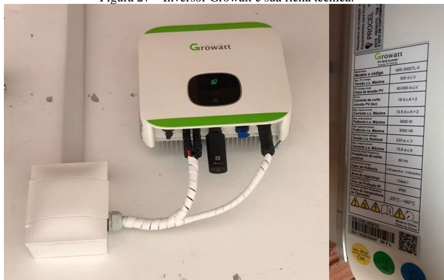
Figura 27 – Inversor Growatt e sua ficha técnica.
