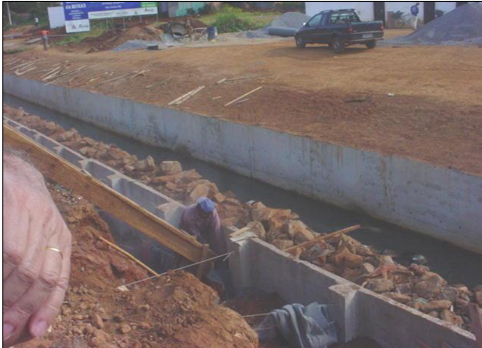
Figura 15- Foto canal detalhe revestimento.
