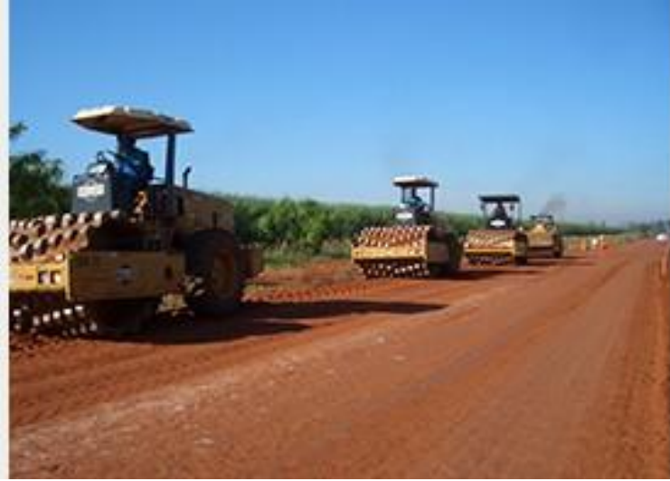
Figura 9 – Compactação com o rolo
