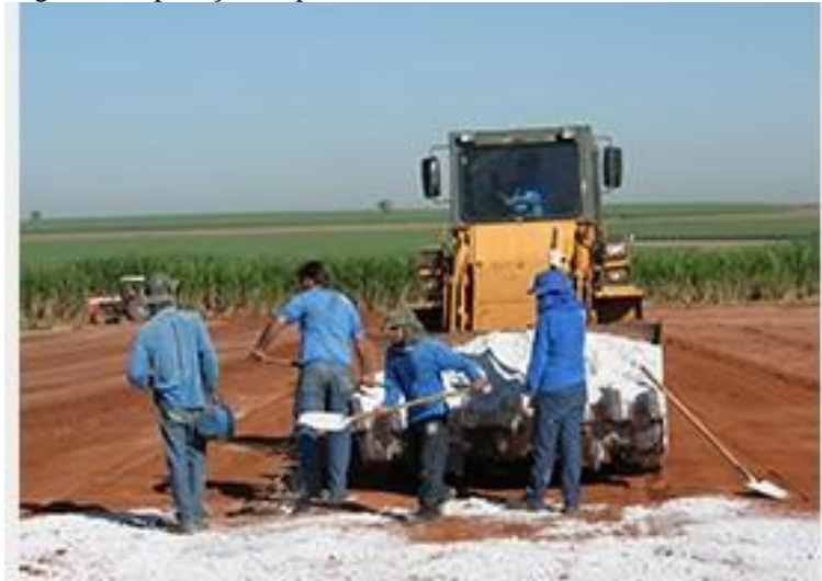
Figura 6 - Aplicação do produto na via.
