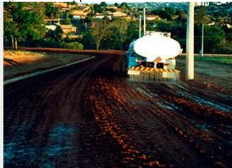
Figura 8 - Caminhão pipa molhando o solo.
