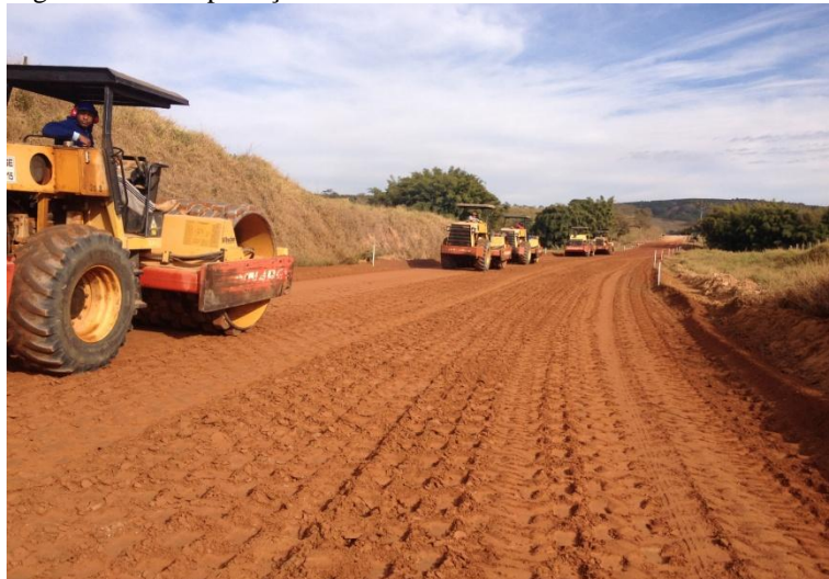
Figura 13 – Compactação do subleito existente.
