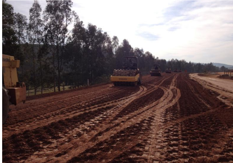
Figura 15 – Compactação com o rolo
