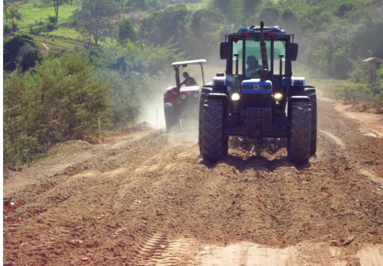
Figura 12 – Homogeneização do subleito existente.
