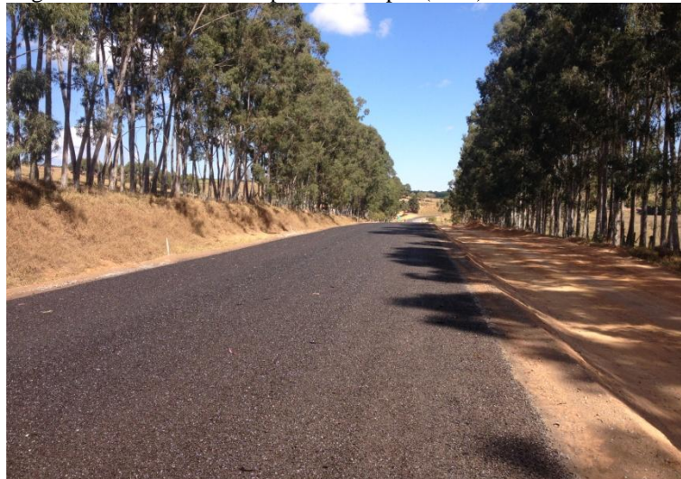
Figura 18 – Tratamento Superficial Duplo (TSD).
