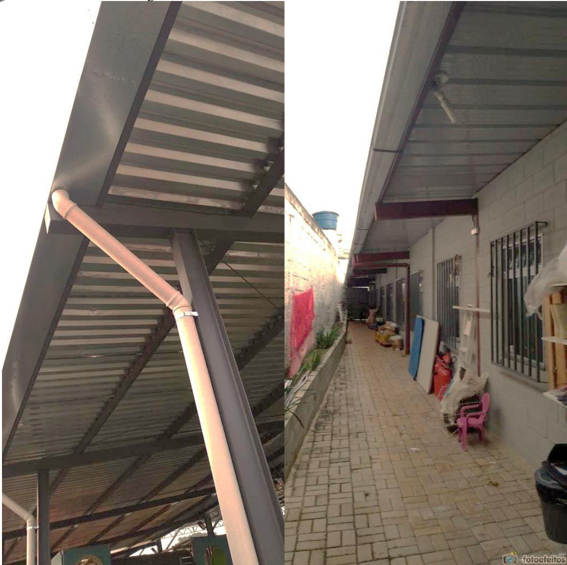
Figura 04 – Sistemas de drenagens existentes.
