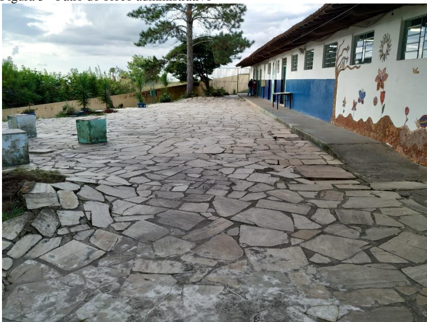
Figura 3 - Pátio do bloco administrativo
