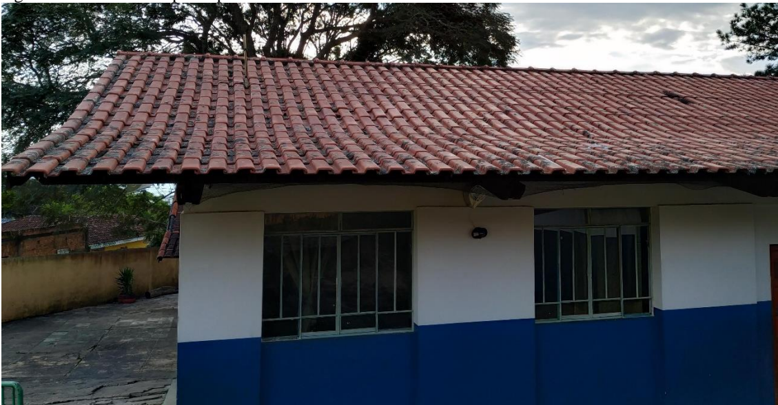
Figura 8 - Telhado composto por telhas cerâmicas
