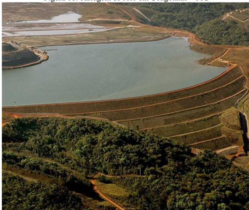
Figura 08: barragem de solo em Congonhas – MG
