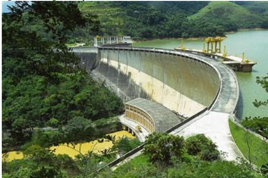
Figura 01: barragem do tipo abóbada da usina hidrelétrica de Funil em Resende - RJ
