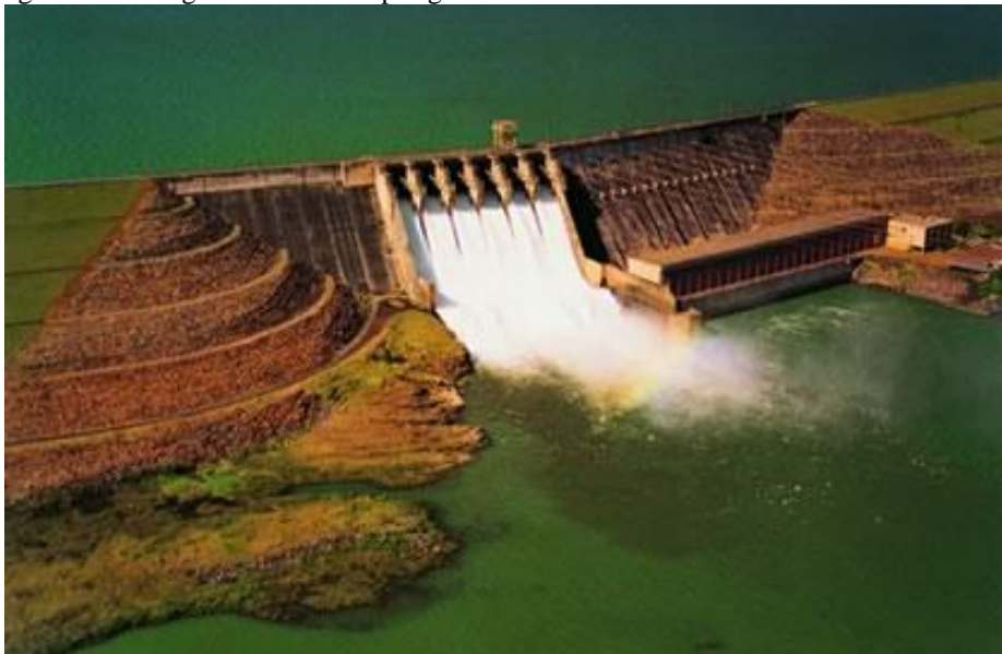
Figura 02: barragem de concreto por gravidade da usina hidrelétrica de Itumbiara – GO
