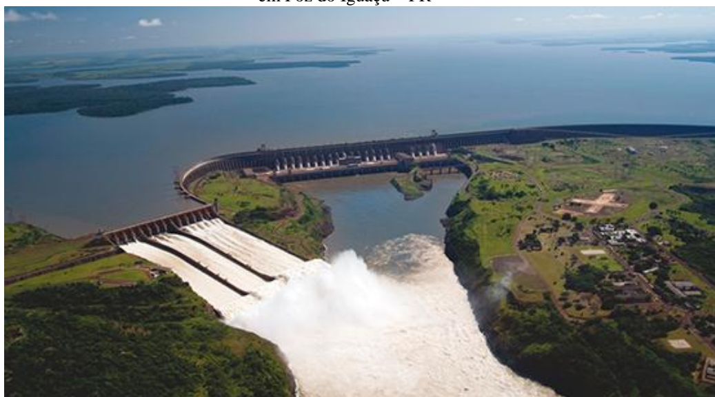
Figura 03: barragem de concreto com contrafortes e por gravidade aliviada da usina hidrelétrica de Itaipu em Foz do Iguaçu – PR
