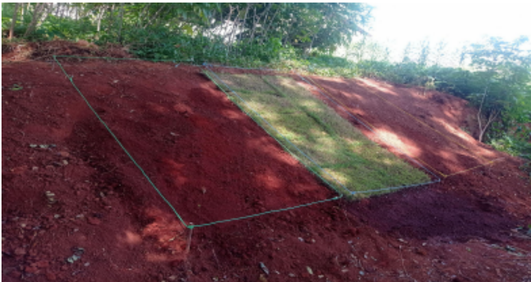
Figura 5 - Demarcação do talude
