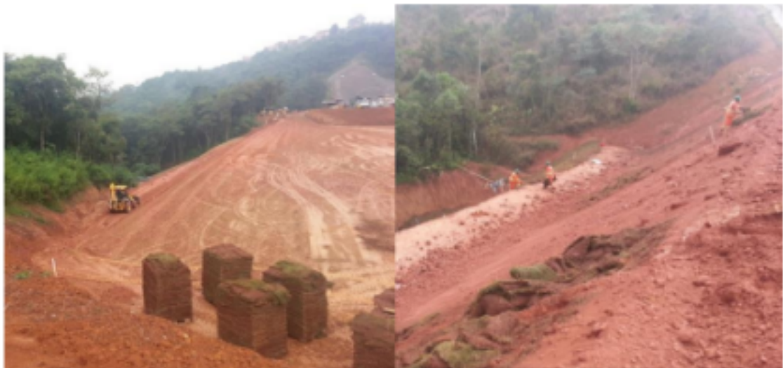
Figura 3 e 4- Gramas em placa e aplicação das placas no Rodoanel Norte - SP
