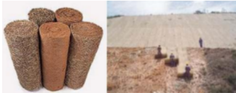
Figura 2 - Rolos de biomantas e aplicação ao solo
