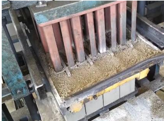
Figura 27: Moldagem dos blocos
