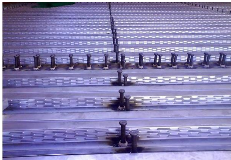
Figura 11 - Conectores de cisalhamento (Stus Bolt)
