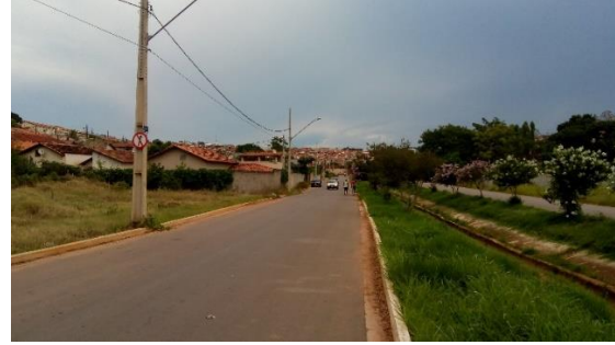
Figura 39: Vista 2, Rua Maria P. Souza e Ribeirão Jardim.
