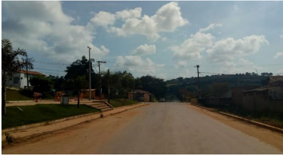
Figura 38: Vista 1, Rua Maria P. Souza
