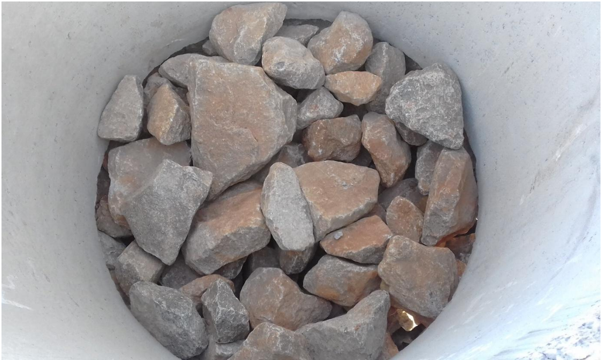
Figura 18 –Preenchimento com pedras no dreno.
