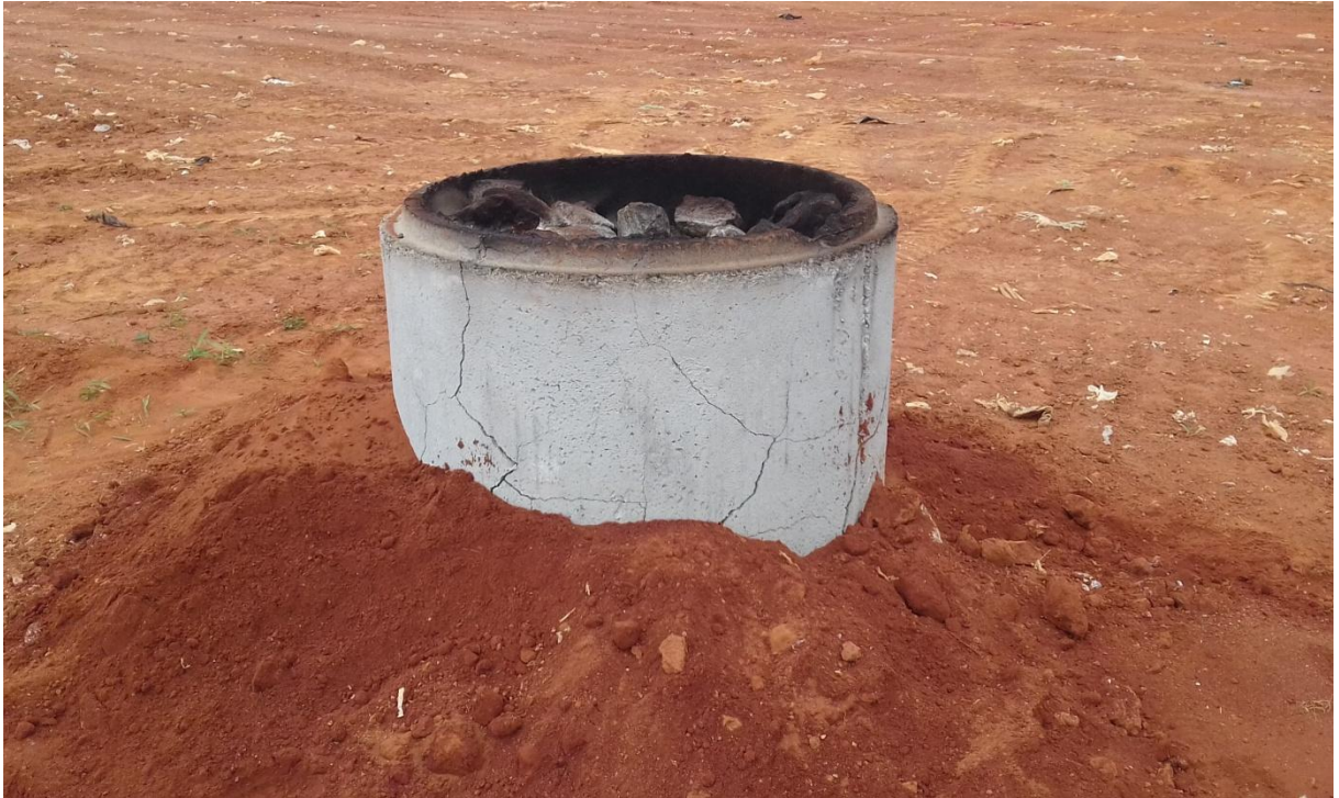
Figura 17 – Dreno de biogás atual.
