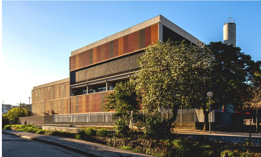
Figura 60 - Fachada da Escola Estadual Nova Cumbica.
