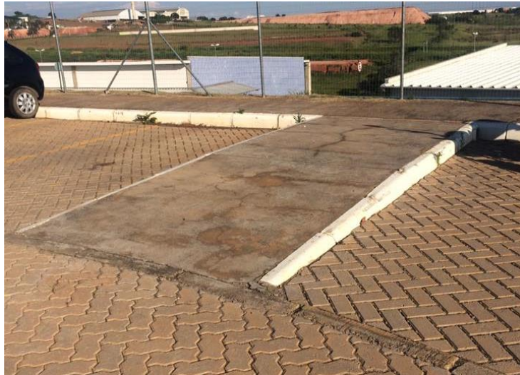
Figura 23 – Rebaixamento da calçada fazendo ligação com a rua. Fonte: A autora, 2016.
