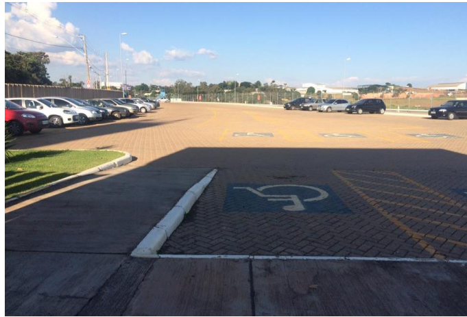
Figura 26 – Estacionamento do bloco A.
