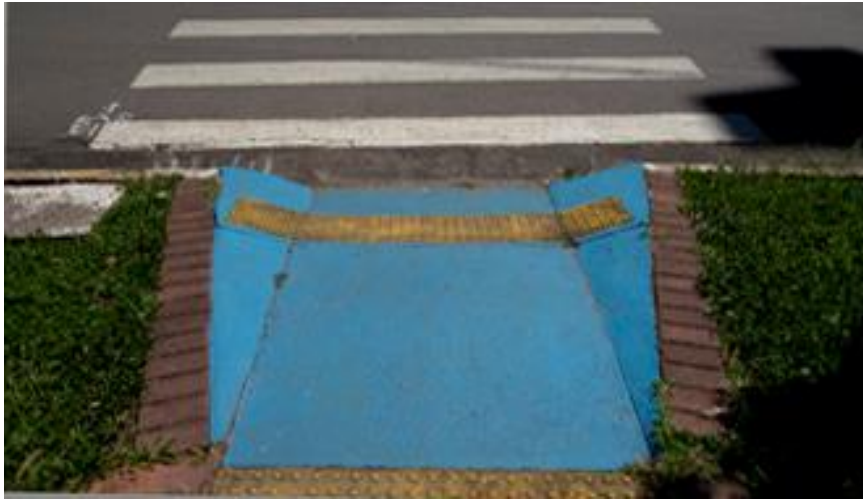
Figura 58 – Rampas de acesso entre a calçada e a rua.
