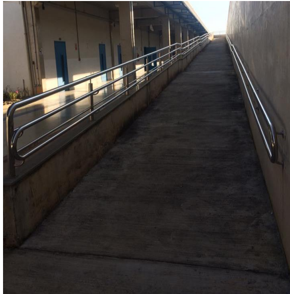
Figura 29 – Rampa de acesso. Fonte: A autora, 2016.
