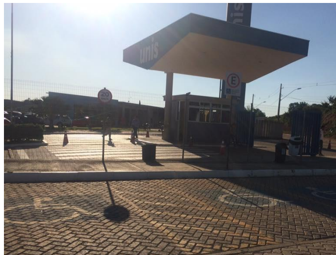
Figura 27 – Guarita vista do estacionamento do bloco A.
