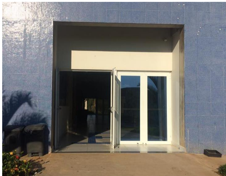
Figura 24 – Porta de acesso ao bloco A, padrão que se estende aos demais blocos. Fonte: A autora, 2016.
