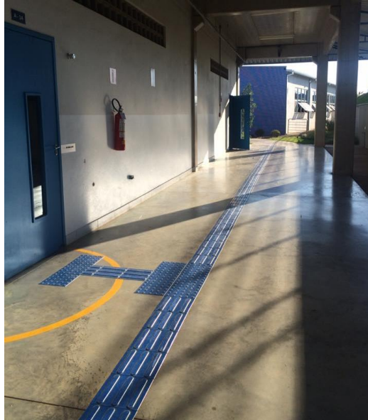
Figura 25 – Corredor no bloco A, contendo piso tátil e descrição em braile nas portas.
