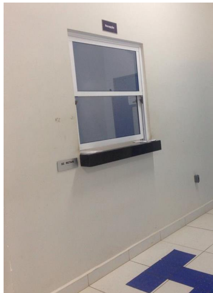
Figura 37 – Balcão de atendimento do bloco A. Fonte: A autora, 2016.
