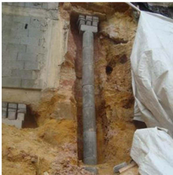
Figura 3 - Estaca Mega de concreto instalada.
