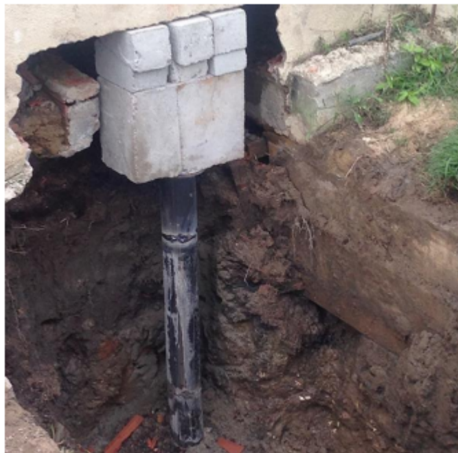
Figura 05 – Estaca Mega metálica instalada.
