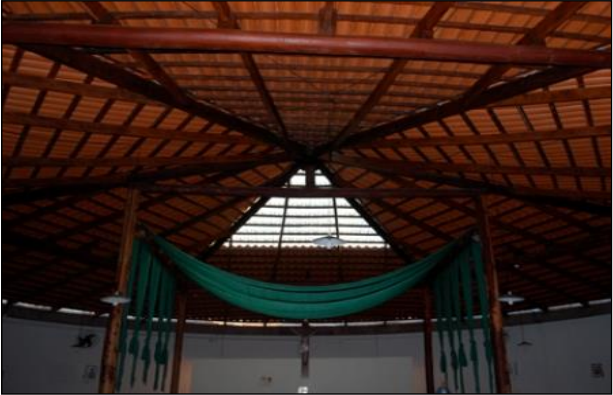
Figura 17 – Detalhe da cobertura Fonte: (BRASIL, 2015k).
