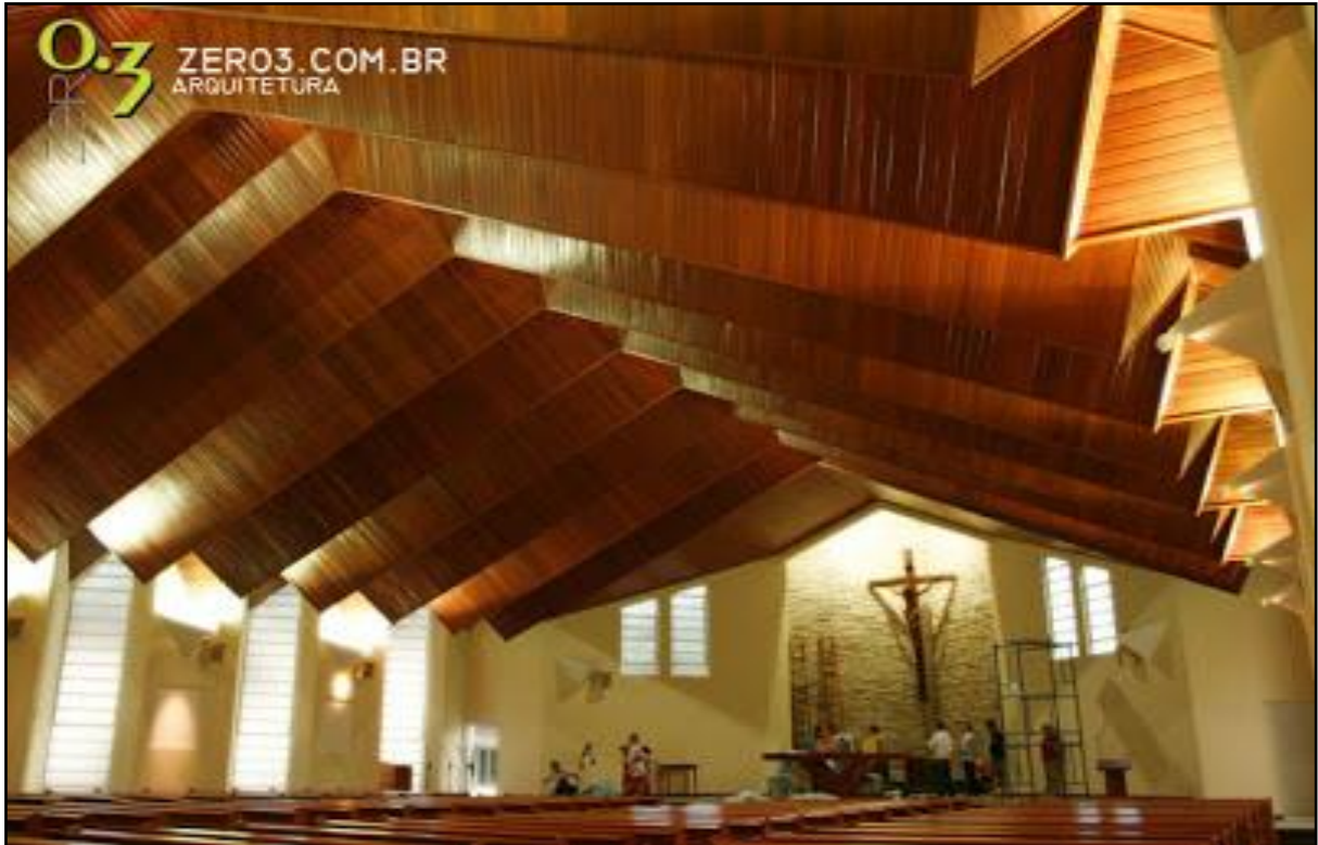
Figura 9 – Detalhe do forro da Igreja de Santa Teresa D'Ávila Fonte: (BRASIL, 2015f).
