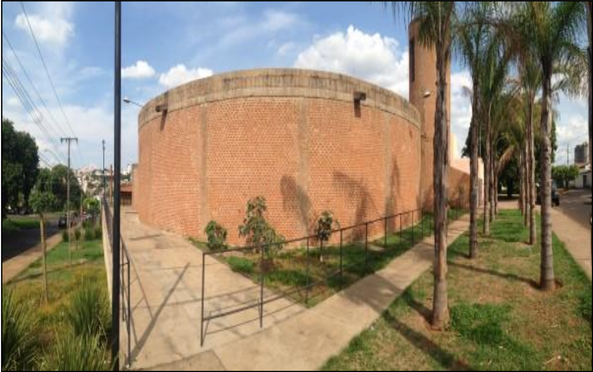
Figura 15 – Rampa de acesso Fonte: (BRASIL, 2015k).
