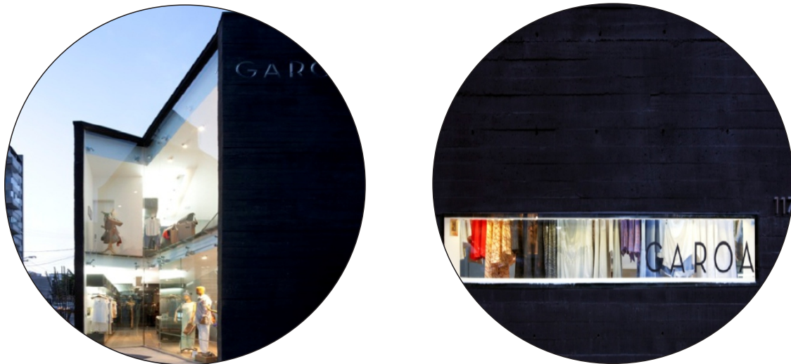
Fig. 66 e 67: Fachada da loja Garoa. O pedestre que passa pelo local consegue ter uma visão ampla do interior da loja.
