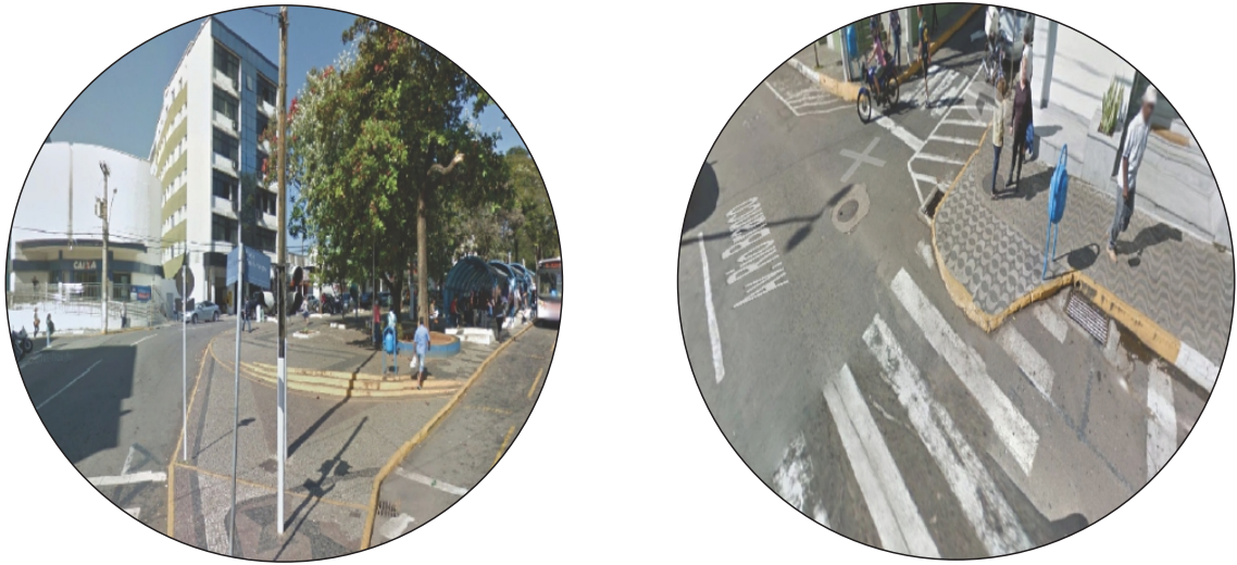
Fig. 38 e 39: Não existe rebaixamento e faixa de alerta e direção nas calçadas.
