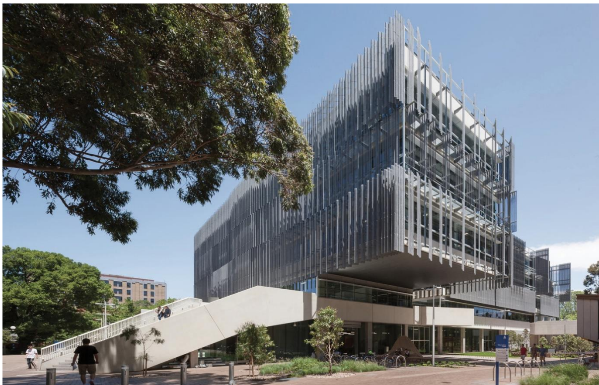
Figura 20 - Prédio da Escola de Design - Universidade de Melbourne.
