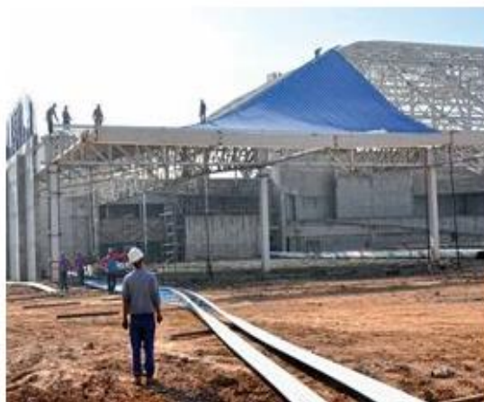
Figura 17 – Vista das telhas zipadas do Santuário Mãe de Deus Fonte: Padre Marcelo Rossi (2015)
