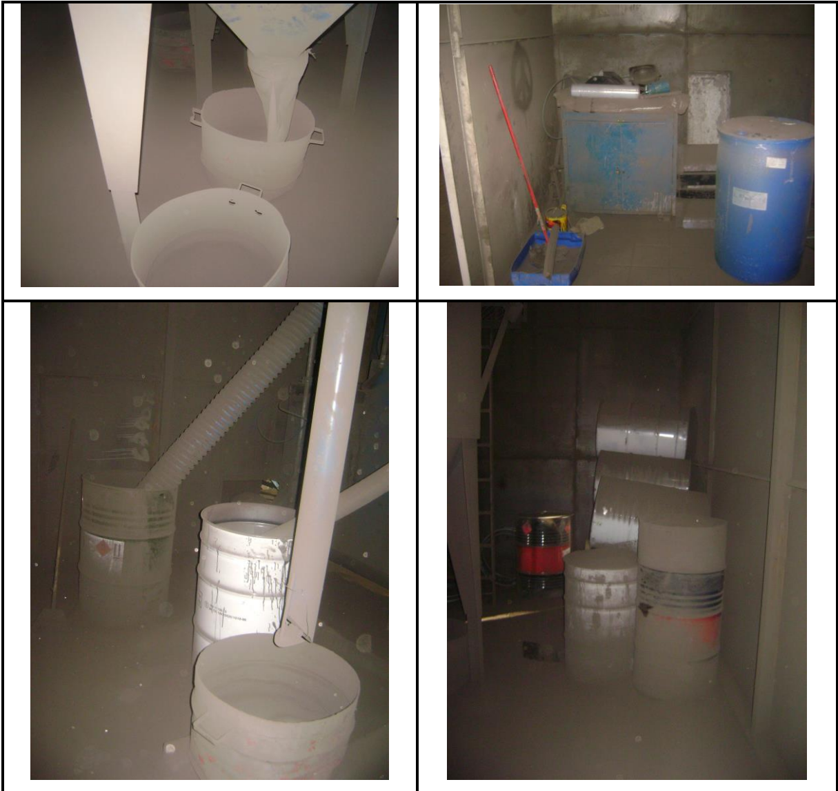
Fotos 01: Cabine da Granalha antes da limpeza
