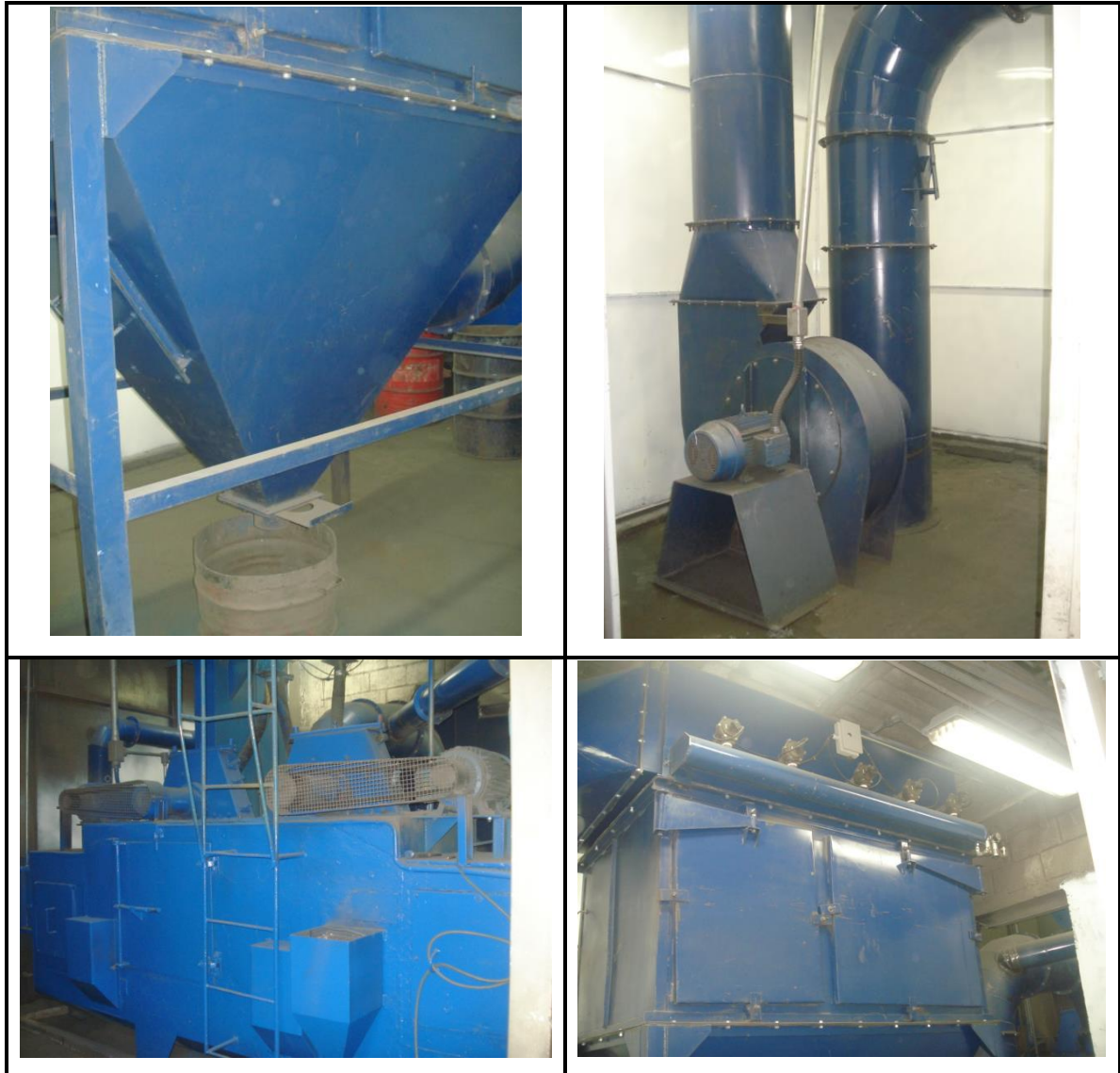
Fotos 02: Cabine da Granalha depois da limpeza
