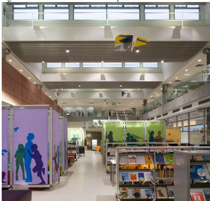
Figura 40 – Área interna com iluminação zenital.
