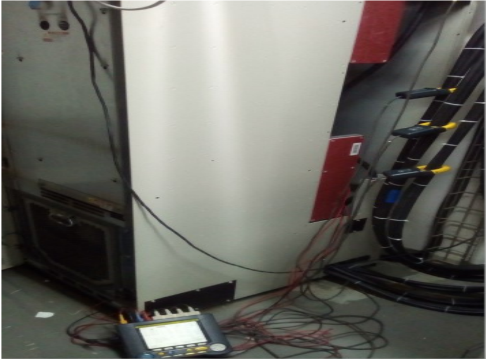
Figura 18- Coletas de dados com inversor a 50%, 30 Hz
