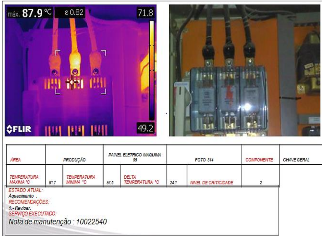
Figura 17: Resultado de análise termográfica.
