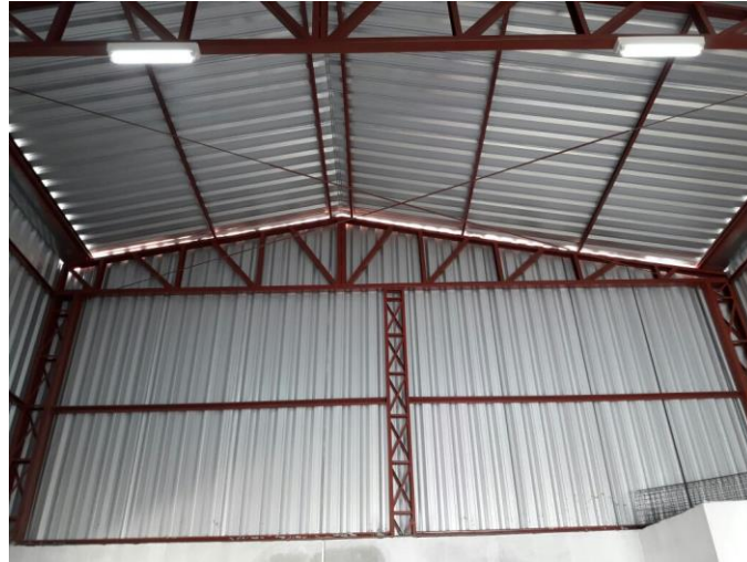
Figura 12: Elementos estruturais do galpão
