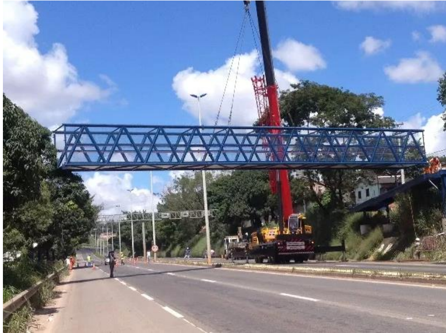
Figura 04 – Treliça plana nas duas faces laterais utilizadas em passarela urbana
