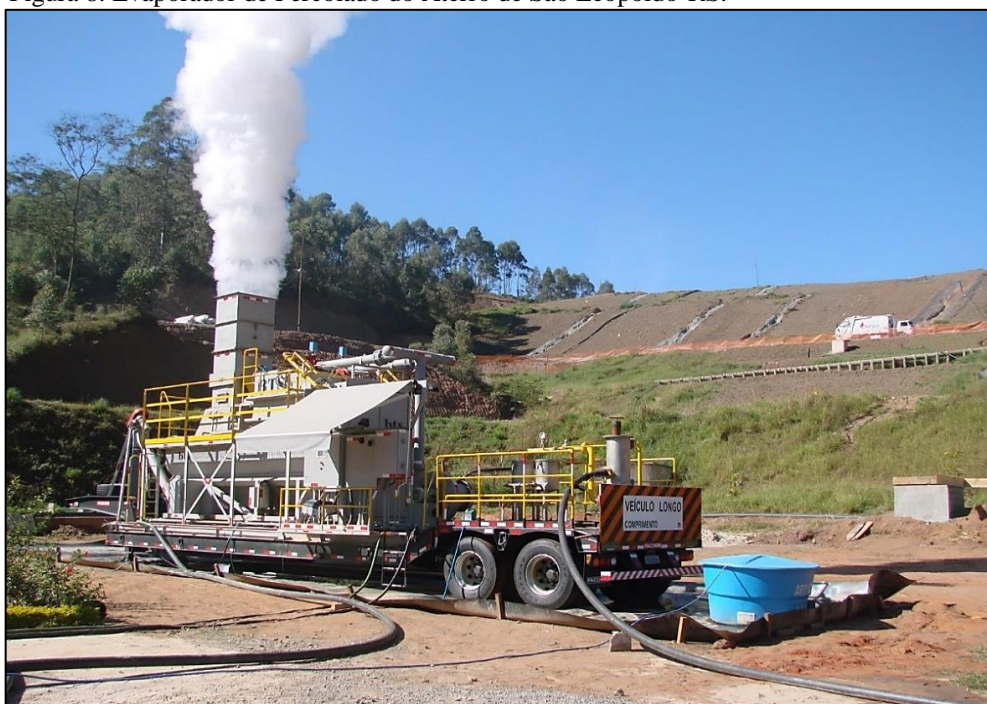
Figura 8. Evaporador de Percolado do Aterro de São Leopoldo-RS.
